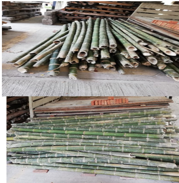
Figura 2 y 3. Puntales de guadua dispuesta dentro del CAV de CVC DAR Centro Sur.
