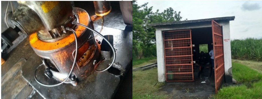
Foto 1 y 2 Estado del pozo
