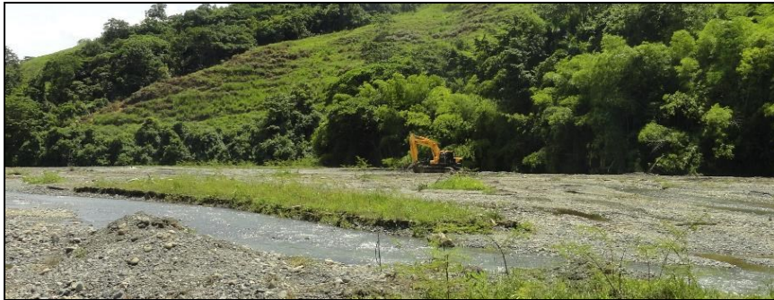
Foto No 3: Retroexcavadora ubicada en la parte de más aguas abajo del polígono minero.
