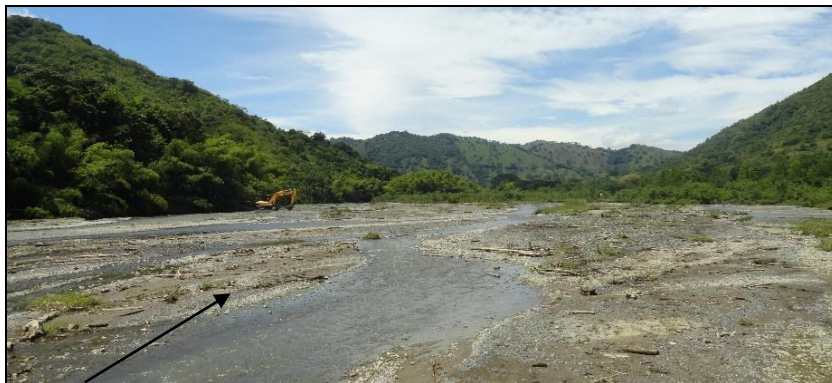
Foto 4: Evidencias de degradación del cauce del río cañaveral.
