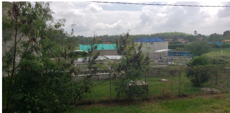
Imagen 2. Planta de Tratamiento de Aguas Residuales Domésticas
