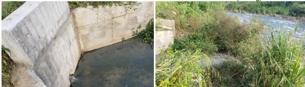
Fotos 2 y 3. Aspecto del deterioro de la calidad del efluente vertido al Río Pance.
