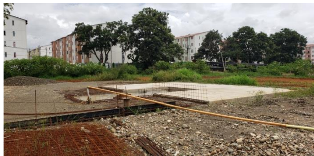
Foto 1. Área para construcción de la PTAR.
