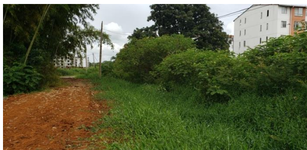
Foto 2. Localización punto vertimiento sobre Zanjón Villegas PTAR Ciudadela del Viento.
