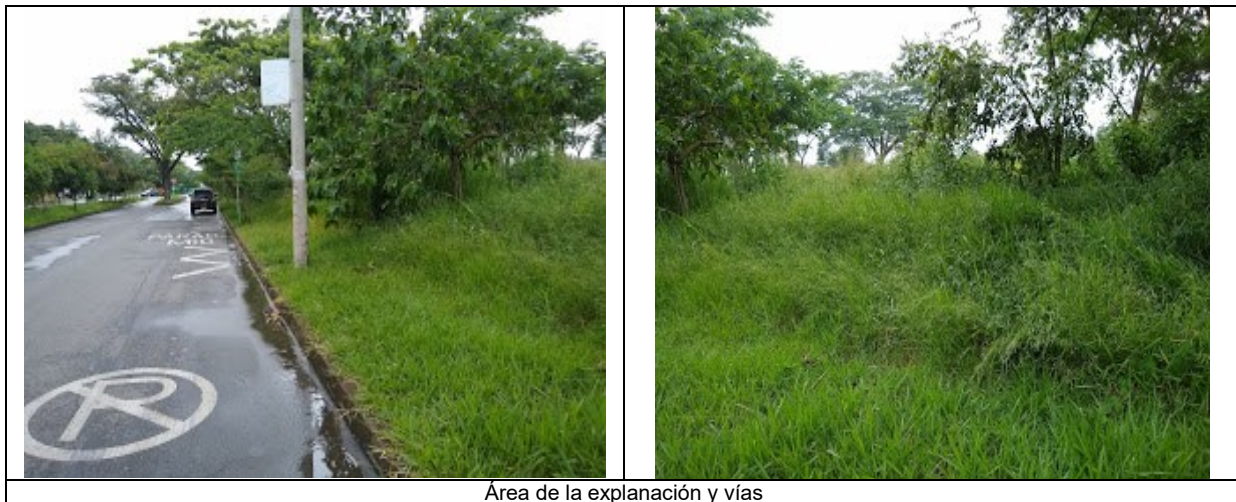
Área de la explanación y vías
