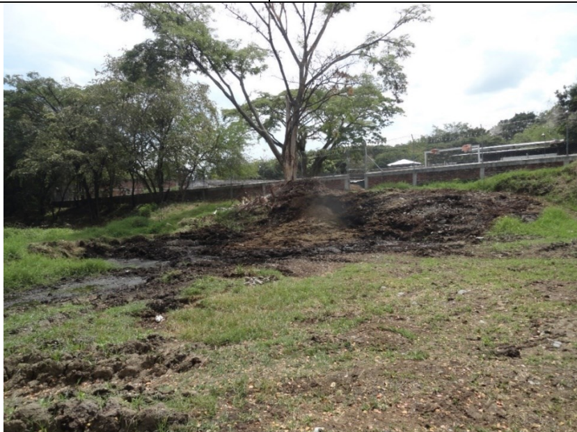
Imagen 9. Zona posterior PTAR Frigotimaná. Disposición de material proveniente de vehículos de transporte animal (Signos de escorrentía y lixiviación)
