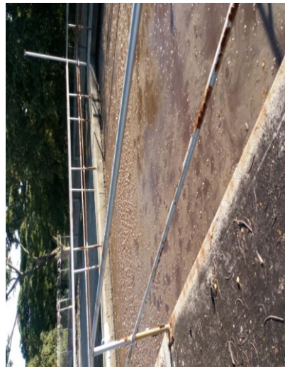
Imagen 4. Filtro Anaerobio de Flujo Ascendente
