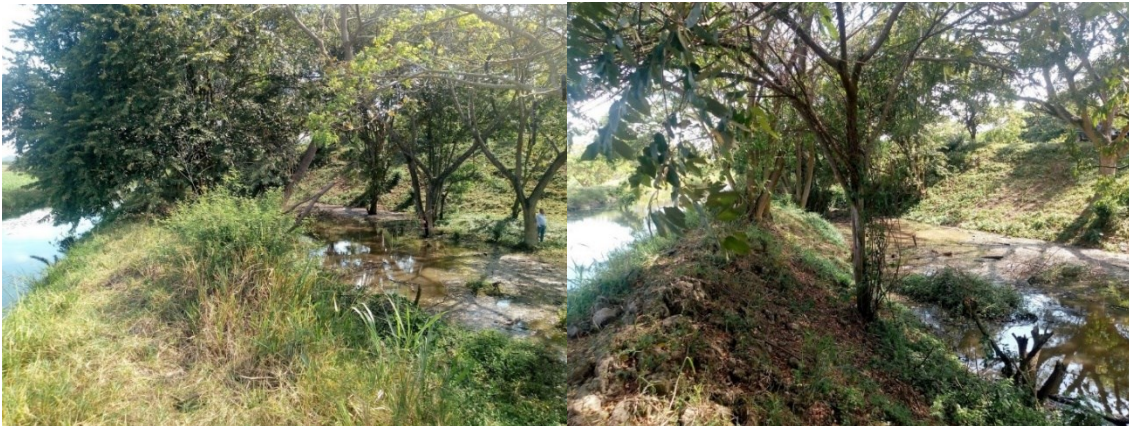
Foto 3 y 4 Disposición del arbolado entre los dos canales del distrito de riego protegiendo taludes Predio La Isla Corregimiento de Morelia, Municipio de Roldanillo
