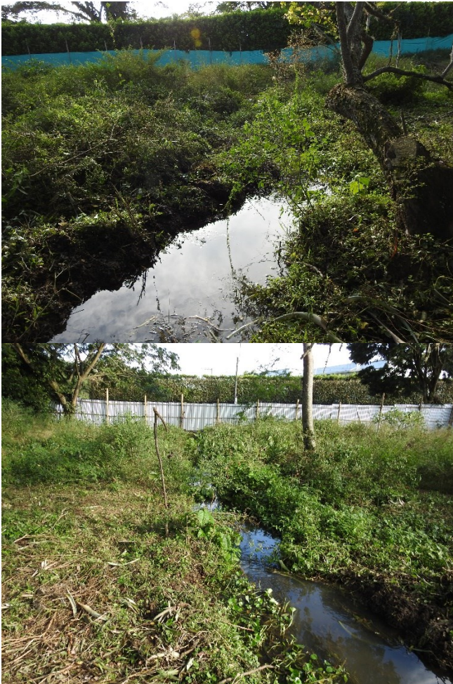
Imágenes 11 y 12. Acequia 6-2 de Pance que cruza el costado sur del predio.
