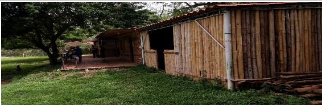
En esta fotografía se aprecia la ubicación de la construcción en madera, que no fue concluido y no se encuentra habitado.
