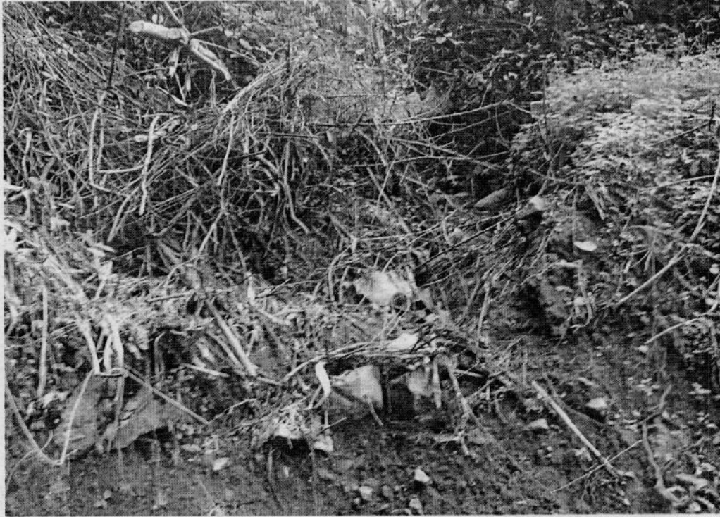
Área de del talud protegido y estabilizado
