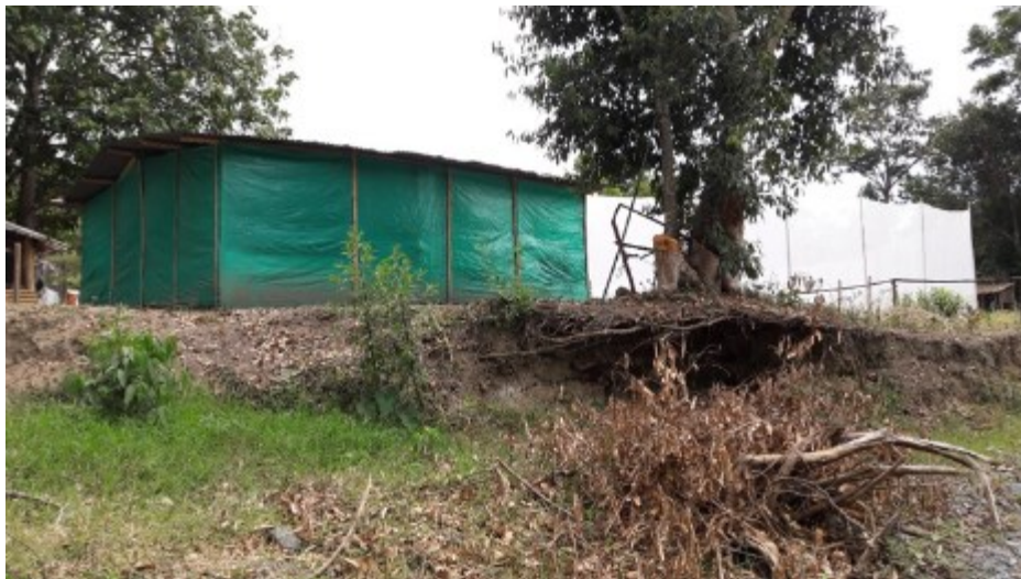
Foto 8: construcciones sobre la franja forestal de la quebrada y bifurcaciones taladas
