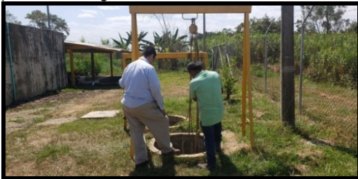
Foto 2. Pozos de llegada y bombeo.
