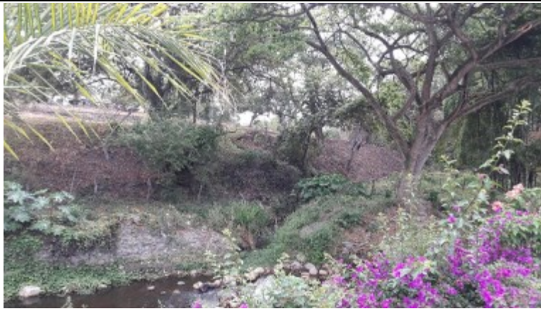
Foto 1: quebrada Artieta. Cauce taponado. Movimiento de tierra.
