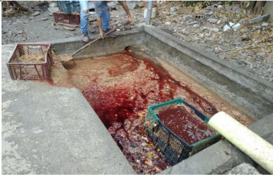
Imagen 5. Cámara donde se realiza recolección manual de sólidos grandes
