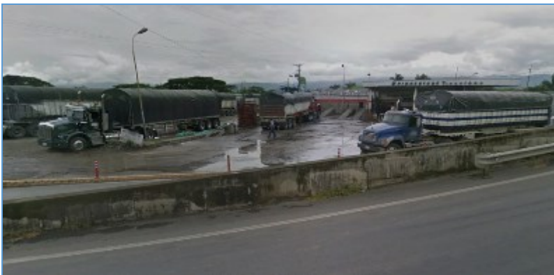
Panorámica del Centro Camionero "Lechugas"
