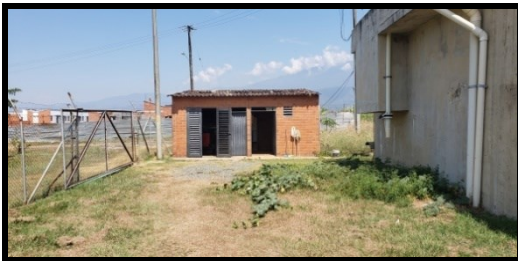
Foto 1. Vista general caseta de operaciones.
