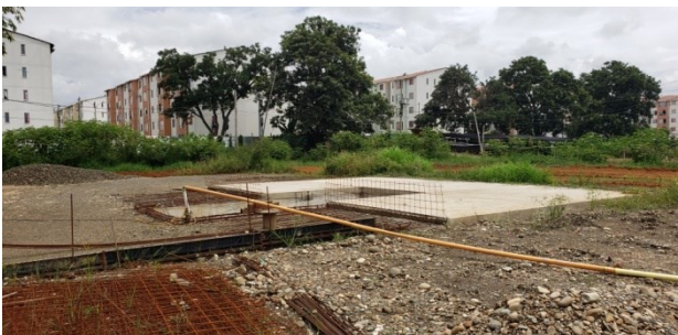
Foto 1. Área para construcción de la PTAR.
