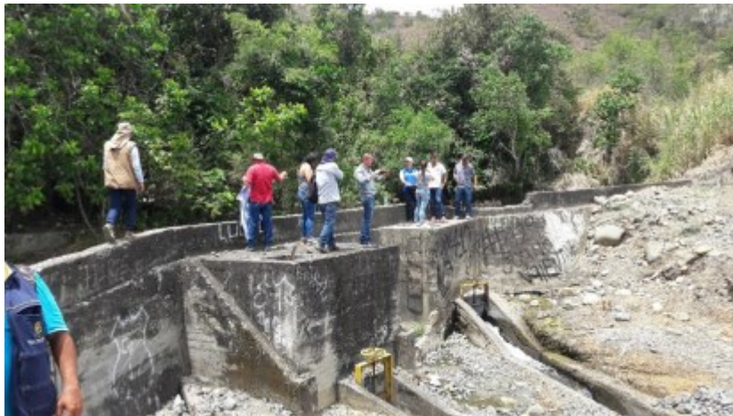
Foto 2: Bocatoma Acueducto San Pedro.
