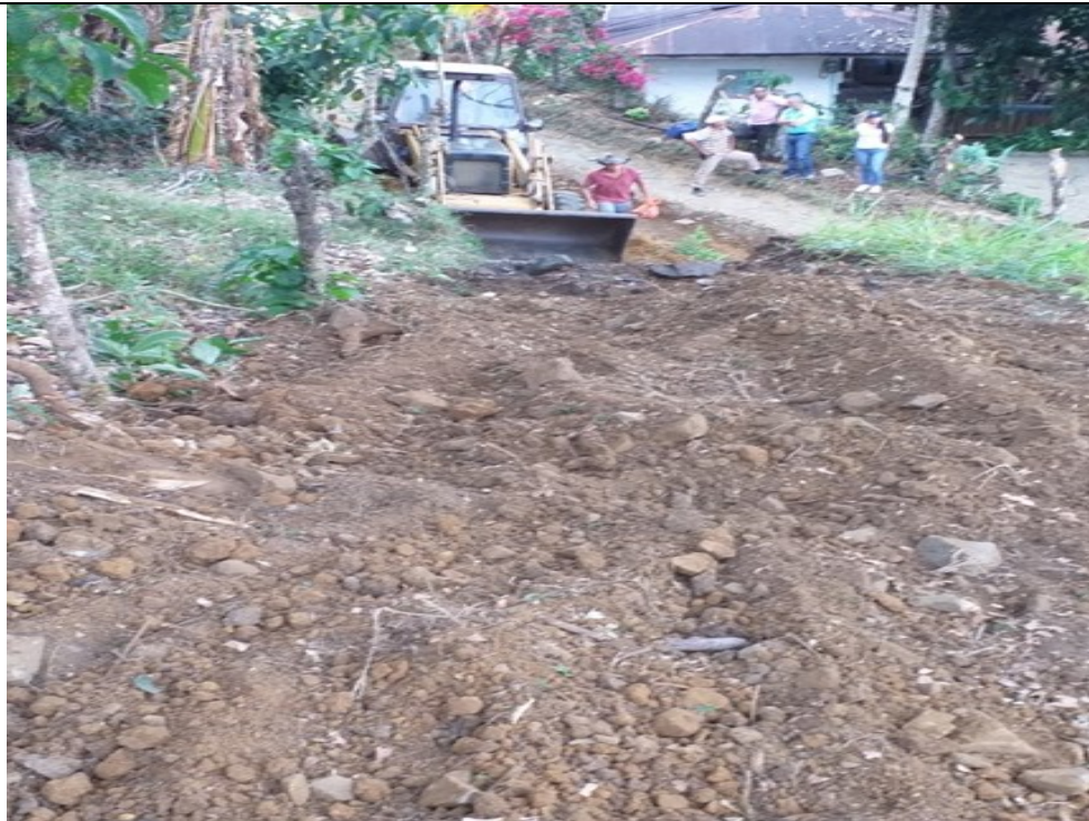
Maquinaria aperturando la vía
