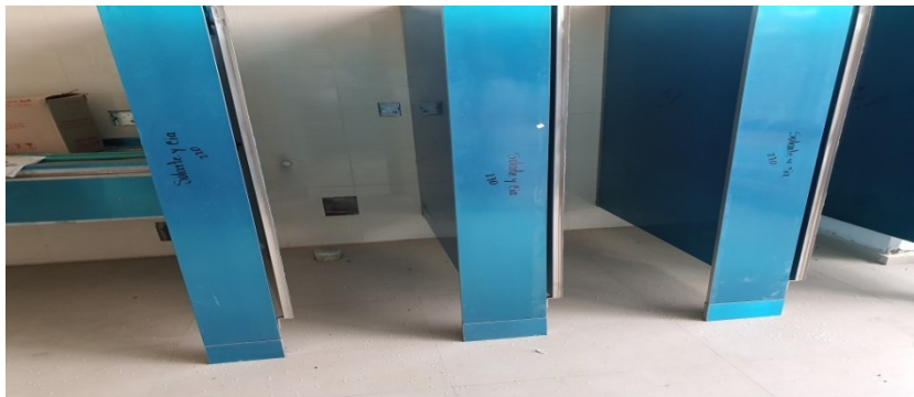
Imagen 2 .Las baterías sanitarias están en construcción.
