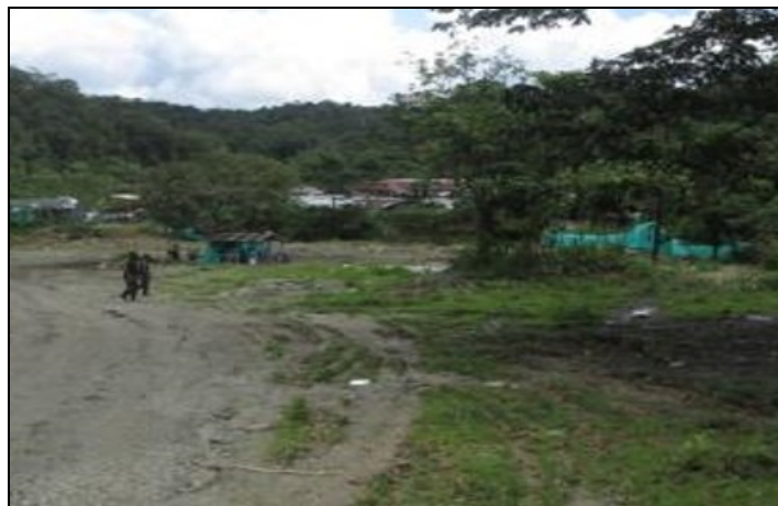
Foto No 4: Zona despejada con la demolición y retiro de equipo y maquinaria, fuente foto Industrias Beni 2017.
