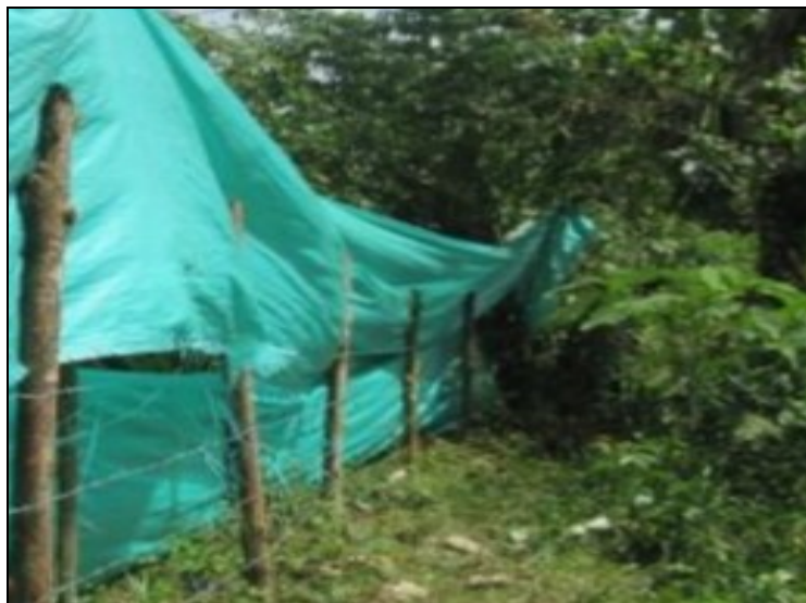
Foto No 1: Cierre perimetral de la arenera Zaragoza.
