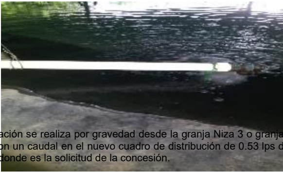
Tanque de almacenamiento de la granja El Palmar, proveniente de la granja NIZA
