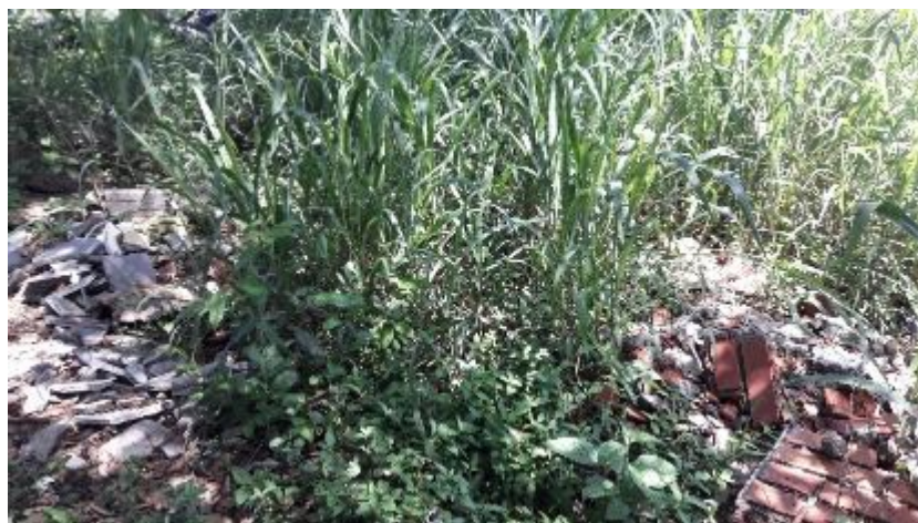
Foto 8: escombros sobre el canal tesorito..
