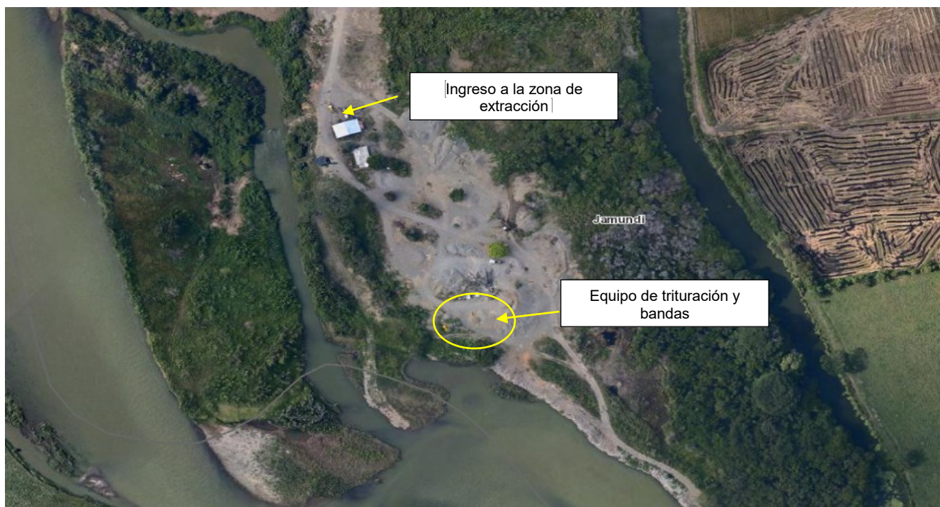
Figura 3. Fotografía aérea del 2013 con el detalle de infraestructura y maquinaria. Fuente GeoCVC
