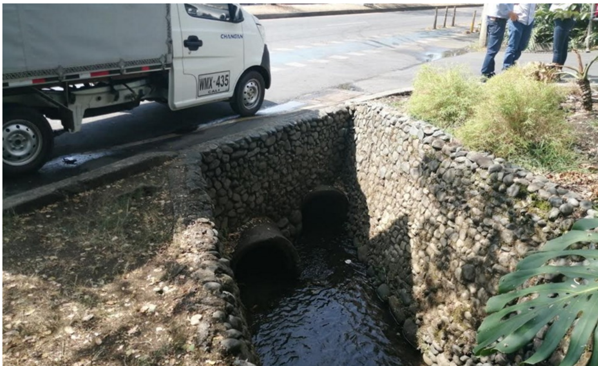
Figura 2. Punto de descarga del alcantarillado pluvial propuesto.
