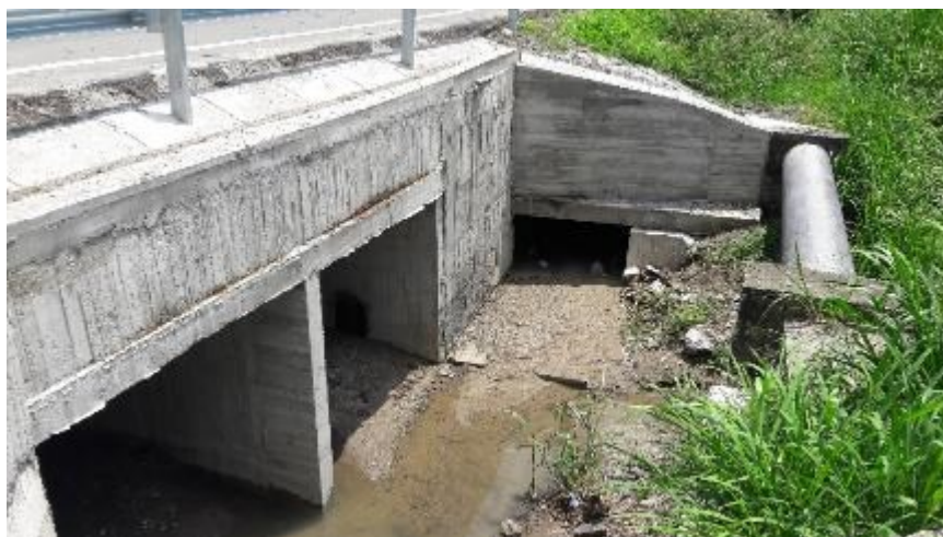
Foto 6: Box coulver sobre la doble calzada.
