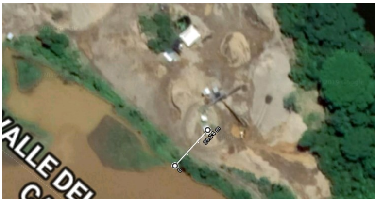
Figura 6. Fotografía satelital del 2019 con la distancia de infraestructura al borde del río (29.8 m). Fuente Googlemaps
