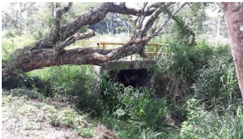
Foto 2: box culver nuevo.
