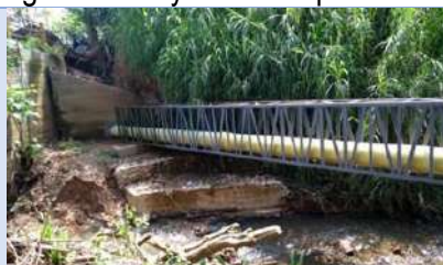
Foto 19. Tramo colector Zuñiga - Las Brisas antes de llegada a viaducto, Caicedonia.
