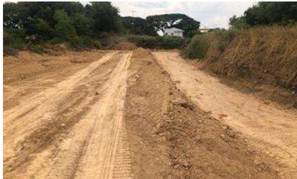
Foto 303. Realce de dique.
