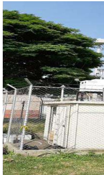
Foto 262 Instalación de equipos Estación de Calidad del Aire de Palmira
