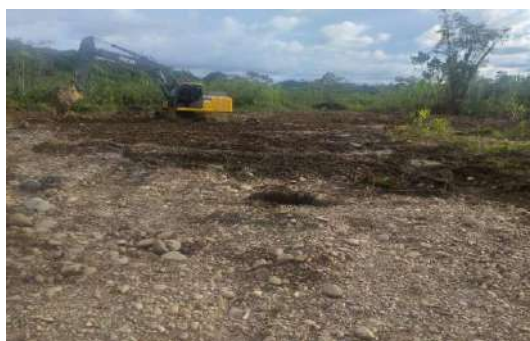
Foto 313. Fosa 11, Sector los cholos, corregimiento de Córdoba, municipio de Buenaventura, estado final de las obras.
