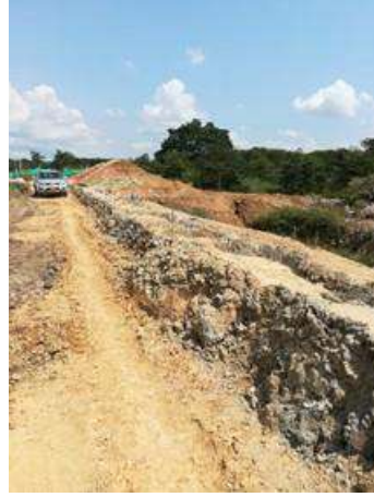
Foto 301. Reforzamiento de dique columnas de suelo-cemento en sector de Brisas del Cauca.
