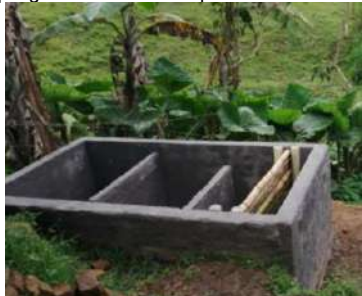
Foto 102. Alternativas tecnológicas implementadas (Sedimentador - Biodigestor - Compostera) en el Municipio de San Pedro.
