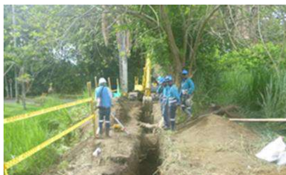
Foto 124. Construcción interceptores PTR Palmira – DAR Suroriente.
