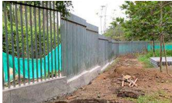
Foto 395 Cerramiento Humedal Cañasgordas
