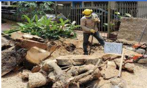
Foto 333 Extracción de raíces
