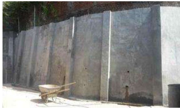
Foto 379 Pantalla en concreto con anclajes para estabilización talud Juana Caicedo
