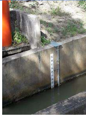
Foto 145. Estación Hidrométrica Derivación 7 río Guadalajara.
