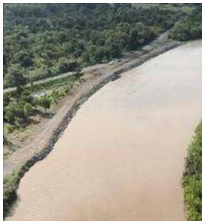
Foto 282. Enrocado de protección construido en la base del río Cauca en el sector Timba Municipio de Jamundí.
