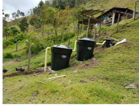
Después: Sistema tratamiento aguas de beneficio
