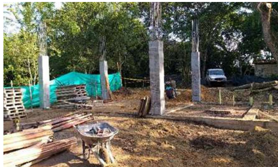
Foto 258 Proceso de fundición de columnas en la ECA.
