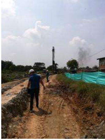
Foto 300. Reforzamiento de dique columnas de suelo-cemento en sector de Brisas del Cauca.
