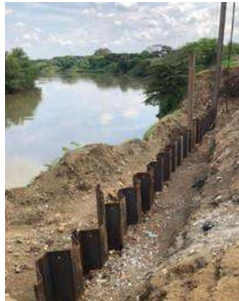
Foto 299. Actividades de hincado de tablestaca.
