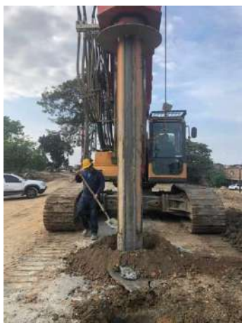
Foto 304. Construcción de columnas pre-excavadas.
