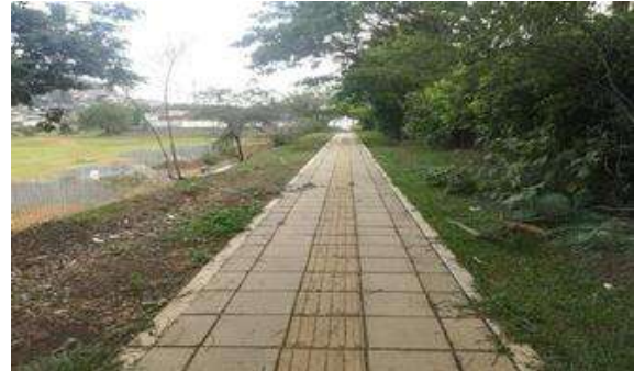
Foto 405 Loseta táctil estriada
