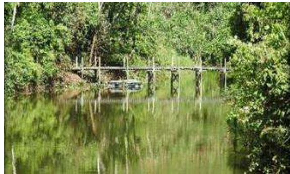
Foto 226. Adecuación de puente para sendero ecoturístico en el Humedal Siracura, Sevilla
