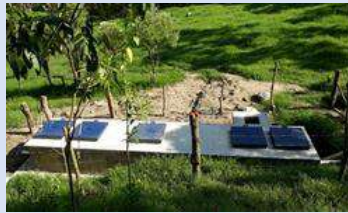
Foto 23. Desarenador, acueducto indígena de El Hormiguero en el municipio de Dagua.
