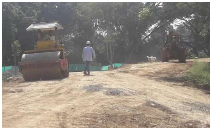
Foto 302. Obra en sector Navarro.
