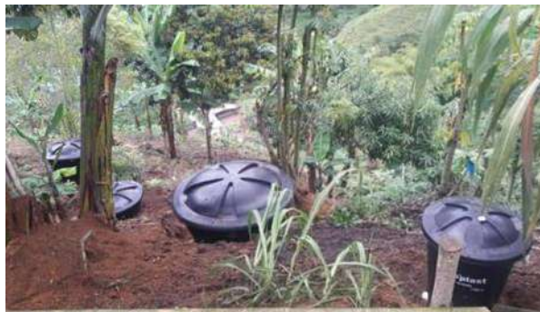
Foto 137. Sistemas de tratamiento de vertimientos originados en el beneficio de Café, El Águila.
