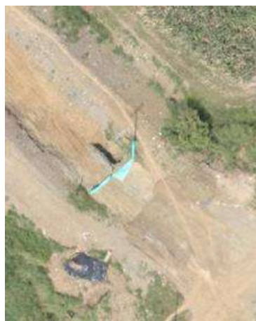
Foto 305. Excavación en sector 1 – Vista aérea.
