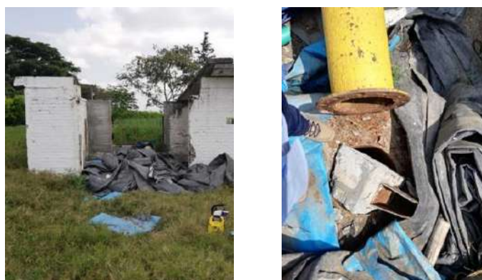
Foto 119. Verificación de las condiciones del pozo Vp-526, localizado en el municipio de Palmira. Fuente: Grupo Recursos Hídricos, DTA. 2019
