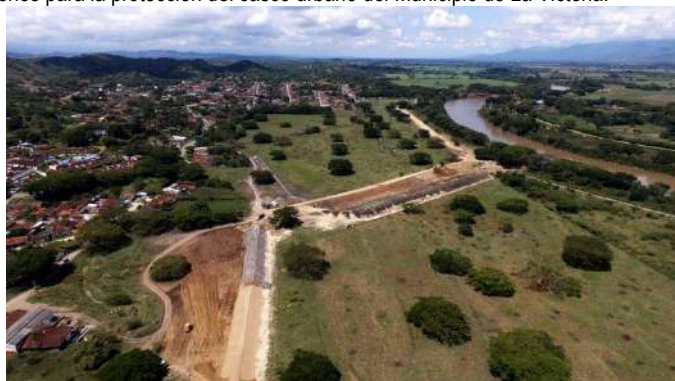
Foto 277. Vista aérea de la conformación del dique de control de inundaciones del Municipio de La Victoria.
