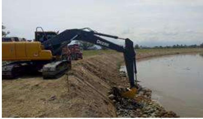
Foto 280. Enrocado de protección construido en la base del río Cauca en el sector San Antonio Municipio de Bugalagrande.
