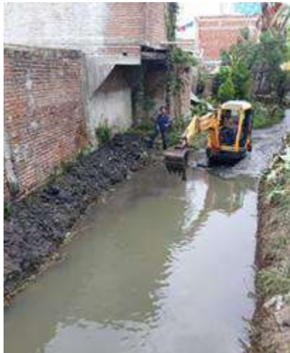
Foto 284. Sección hidráulica descolmatada del cauce de la quebrada San Jose Municipio de Sevilla.
