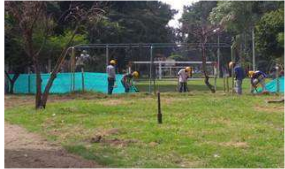
Foto 393 Construcción de cerramiento perimetral
