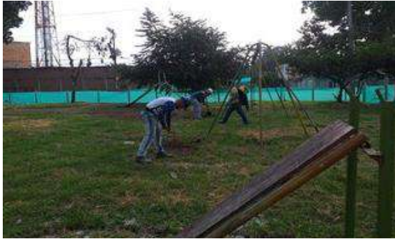
Foto 392 Excavación y retiro de material
