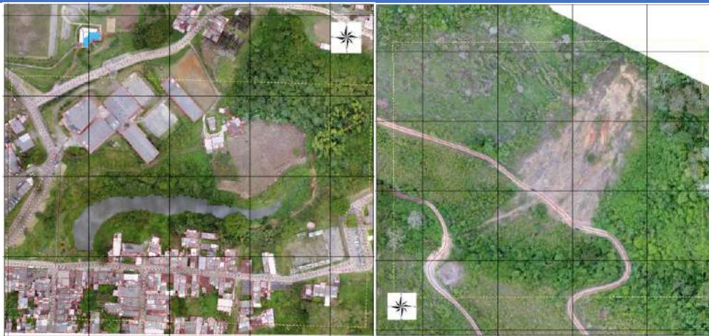
Foto 109. Humedal Siracusa, zona urbana del Municipio de Sevilla, octubre de 2019; Deslizamiento en el Municipio El Cairo, corregimiento La Palmera – El Edén.
