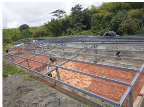
Foto 134. Construcción de lechos de secado en la PTAR del municipio de Versalles.
