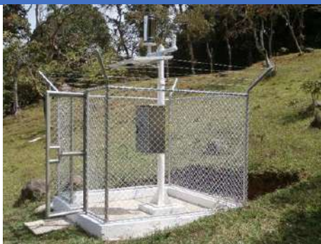
Foto 140. Estación pluviométrica La Clarita.
