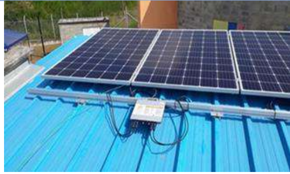
Foto 352 Implementación de sistema solar fotovoltaico e iluminación eficiente
