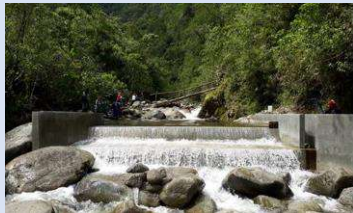
Foto 22. Bocatoma, acueducto indígena de El Hormiguero en el municipio de Dagua.
