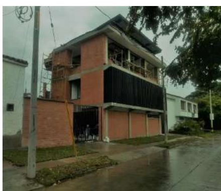
Foto 2. Construcción sede DAR Suroriental-Palmira.
