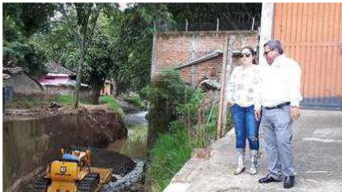
Foto 279. Sección hidráulica descolmata del cauce del río Roldanillo.
