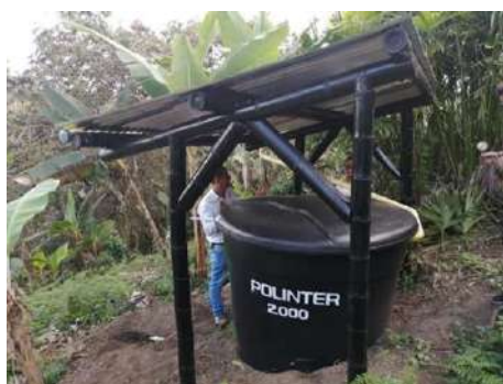
Foto 148. . Instalación de reservorios de aguas lluvia, vereda Tarritos, Argelia.
