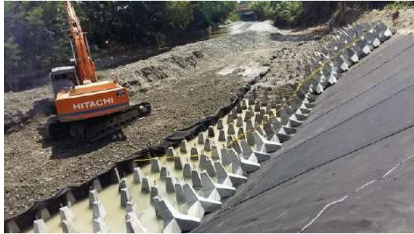
Foto 297. Tetrápodos contruidos para protección contra erosión marginal en la base del rio Bugalagrande.
