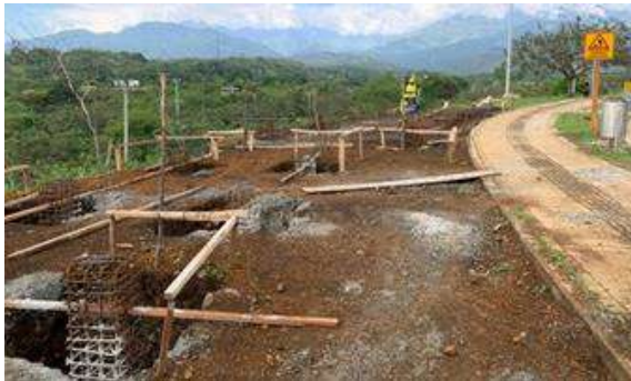
Foto 394 Cimentación Ecoparque El Embudo
