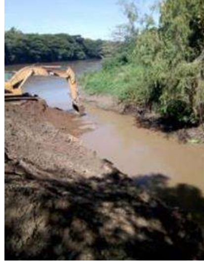
Foto 290. Descolmatacion en la desembocadura Rio Pescador a Rio Cauca.
