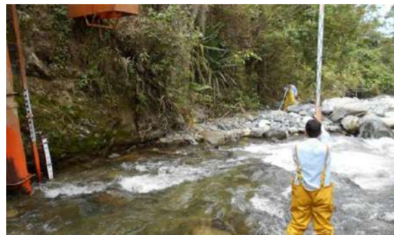
Foto 114. Mantenimiento y seguimiento realizado en la estación Río Bolo-Los Minchos (municipio de Pradera).
