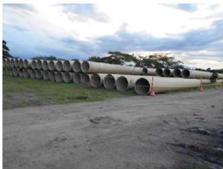
Foto 133. Aprestamiento de materiales y construcción del cerramiento en el predio de la PTAR.
