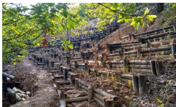
Foto 311. Obras biomecánicas de contención (trinchos), Cerro La Bandera, Santiago de Cali.
