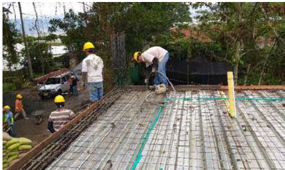
Foto 257 Fundición de vigas de amarre en instalación de la base para el mezzanine de la ECA.
