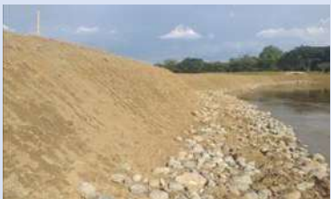
Foto 4. Obra de control de erosión sobre la margen izquierda del río Cauca sector Caramanta municipio de Bugalagrande.
