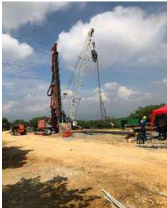
Foto 298. Actividades de hincado de tablestaca.
