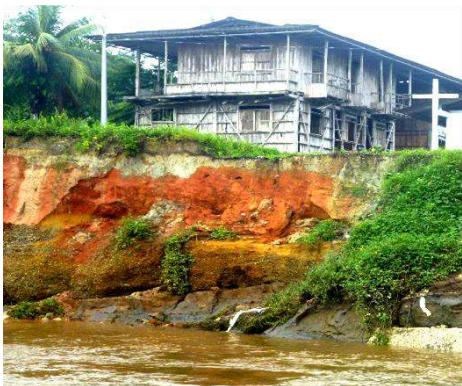
Foto 267. Erosion de orilla rio Yurumanguí - Buenaventura.
