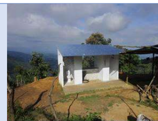
Foto 21. Bateria sanitaria: incluye ducha, lavadero y baño. Sistema de Tratamiento de Aguas Residuales para la comunidad indígena de Mateguadua en el municipio de Florida.
