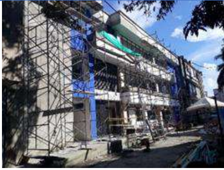
Foto 320. DAR Pacifico Oeste. Fachada principal durante los últimos trabajos de obra.
