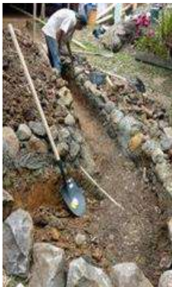
Foto 254 Sistemas fito-depuradores para descontaminación de aguas grises, Cali
