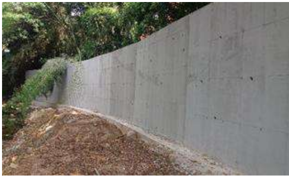
Foto 378 Muro en concreto sobre caisson para protección orilla Bella Suiza
