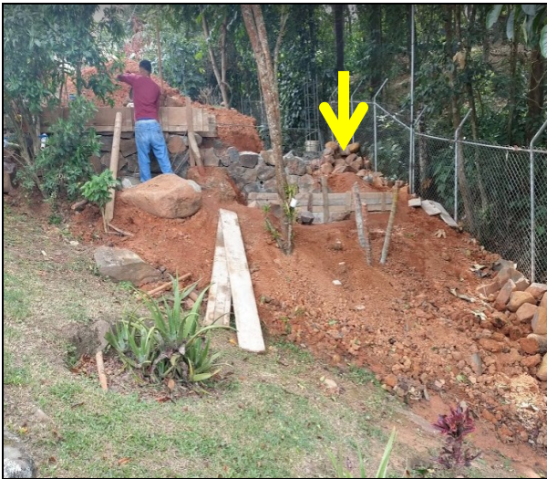
Imagen 6. Vista de la prolongación del terreno para área de kiosco (Flecha indica la ubicación del drenaje intermitente).
