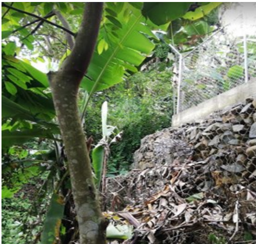
Imagen 2. Vista lateral del gavión hacia la quebrada la Chorrera.
