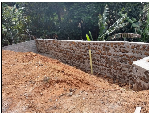
Imagen 4. Vista del muro en piedra y área faltante por llenar.
