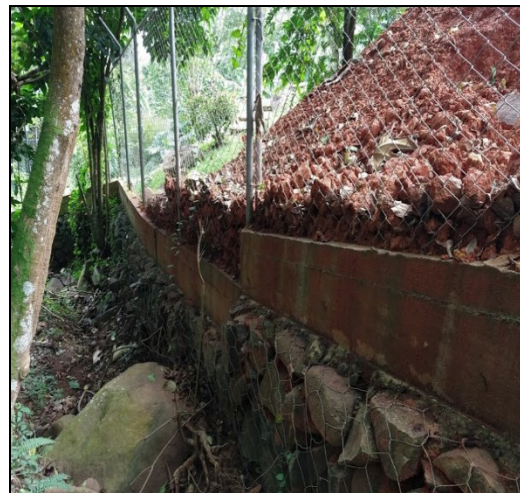
Imagen 3. Vista del gavión hacia el drenaje intermitente.
