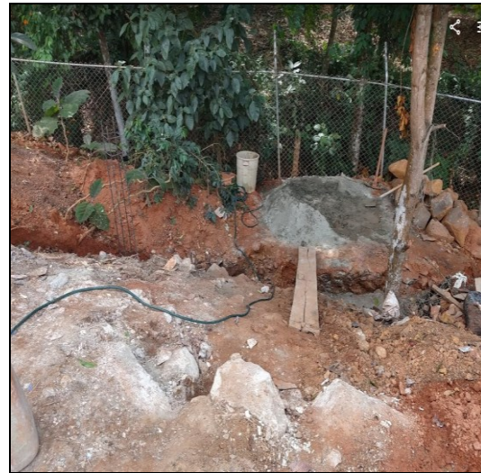
Imagen 7. Vista de excavación para fundición de columnas del kiosco.
