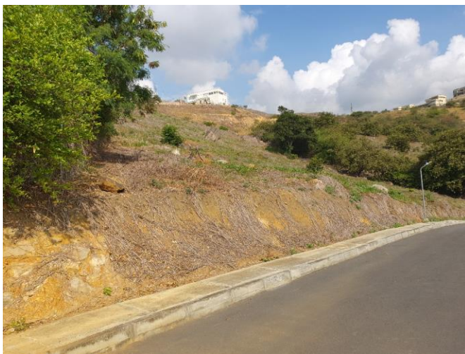
Foto 1. Vía con poca pendiente CVC. 2019
