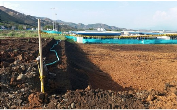
Fotografía 3: Explanación vista sur, fuente propia
