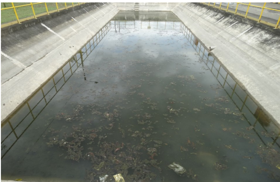
Piscina de evaporación
