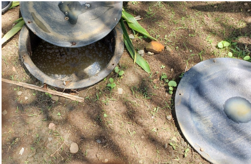
Foto 2. Tanque séptico prefabricado.
