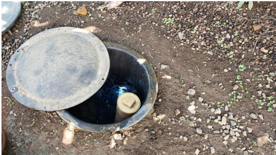
Foto 3. Filtro anaerobio prefabricado.
