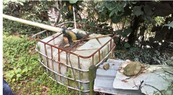
Foto 2 B. Pozo de succión nuevo
