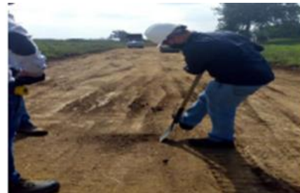
Foto 31. Inspección especialista geotecnia
