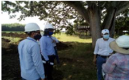
Foto 28. Inicio recorrido replanteo del dique
