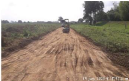
Foto 30. Base del dique
