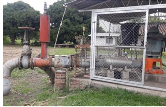
Foto 42. Obra captación agua subterránea, municipio de Guacarí –DAR Centro Sur.
