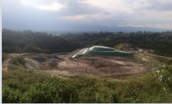
Foto 78 Relleno de seguridad La Esperanza - Celda Fase 2A
