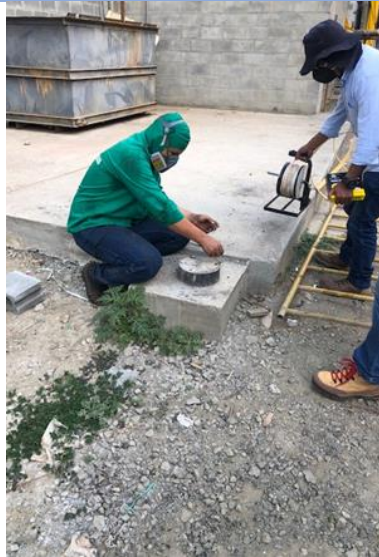
Foto 37. Verificación de construcción de pozos de monitoreo, empresa A y G Ingeniería municipio de Palmira
