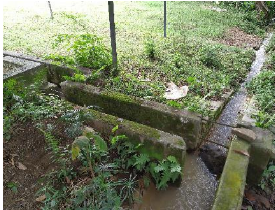
Foto 43. Obra captación agua superficial – predio Aguaclara, municipio de Palmira –DAR Suroriente.
