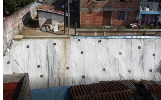
Foto 89 Protección de talud con mantacreto y geodrén planar. Parque La Horqueta-Comuna 20
