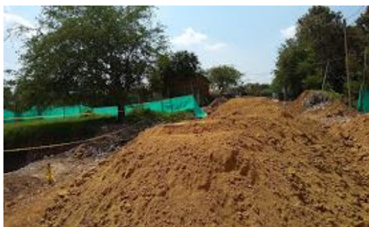
Foto 12. Seguimiento Tramo V-3 Samanes Jarillón Río Cauca.
