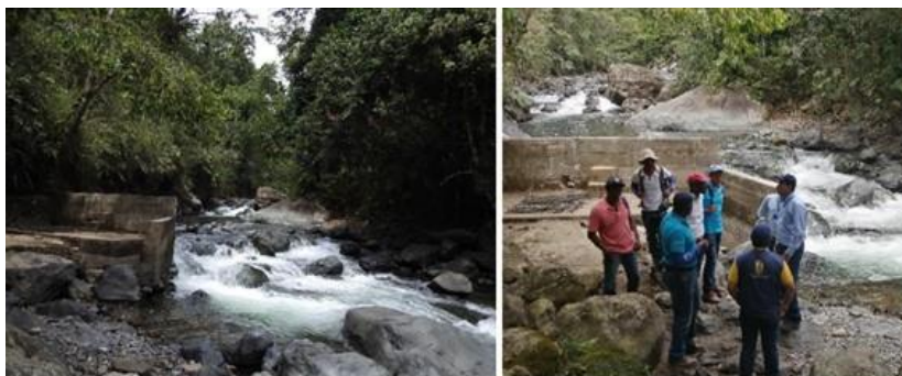
Foto 81. Visita de inspección ocular a la bocatoma del Acueducto Regional Acuasur – Robles-Jamundí.
