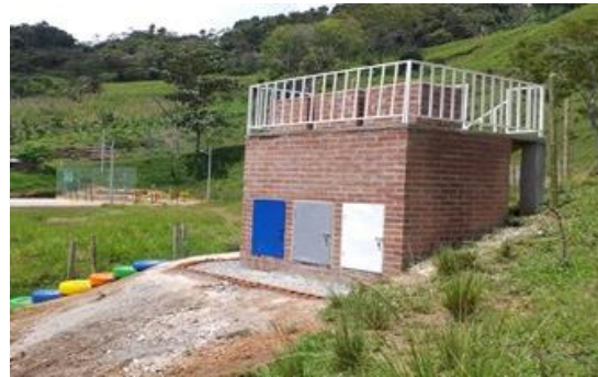
Foto 54. Implementación de Iniciativa Ambiental Comunitaria. Construcción centro de acopio corregimiento Aures, municipio Caicedonia. Fuente: Proyecto Guardabosques 2020.
