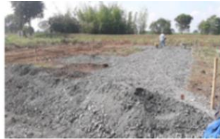
Foto 29. Descapote área campamento y base granular
