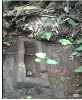
Foto 44. . Obra captación agua superficial – predio La Emboscada, municipio de Yumbo –DAR Suroccidente.
