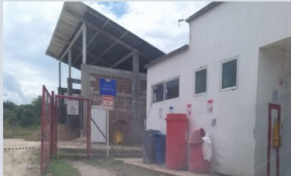
Foto 79 Estructura de cubierta de la zona de tratamiento de residuos.
