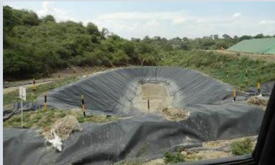
Foto 80 Impermeabilización de la laguna de almacenamiento de aguas lluvias
