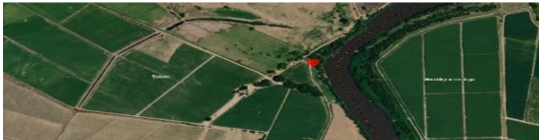
Imagen 3, Ubicación de la afectación en franja Forestal, Fuente GeoCVC, Recuperado de:
