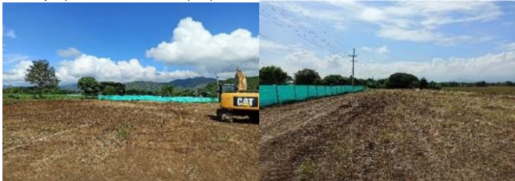
Imagen 4 y 5, Explanación en el predio, Fuente propia.
