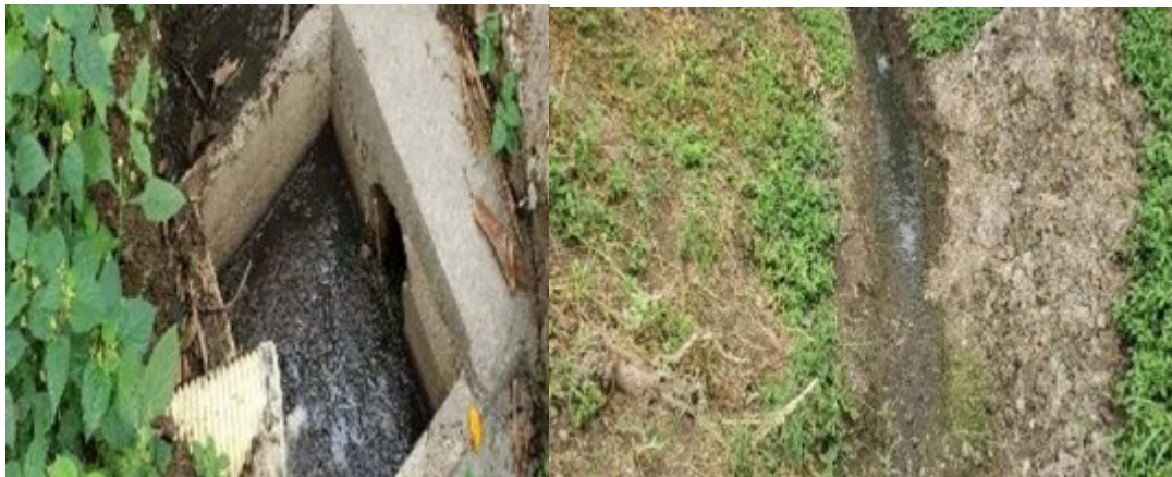
Fotos 7 y 8: tubería de descarga del lavado de los pollos y vertimiento del lavado de cocheras.
