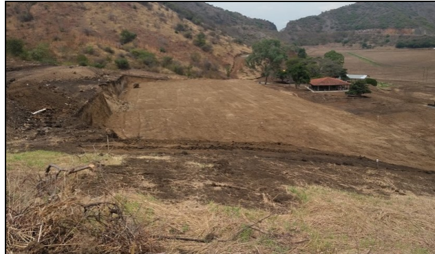
Imagen 1. Vista de la Terraza No. 1.
