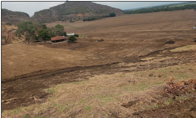
Imagen 2. Vista de la Terraza No. 2.
