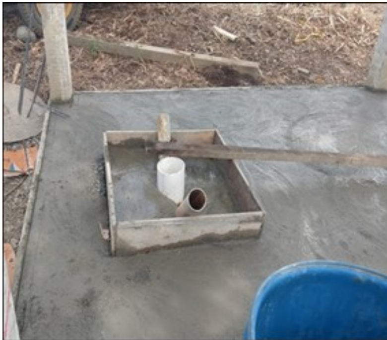
Imagen 6. Vista de la boca del pozo modificada y respiradero.
