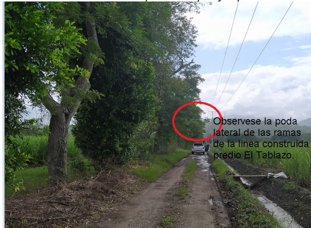
Foto 1. Obsérvese la labor de podas laterales de las ramas de los árboles sobre la línea construida a la altura del predio El Tablazo.
