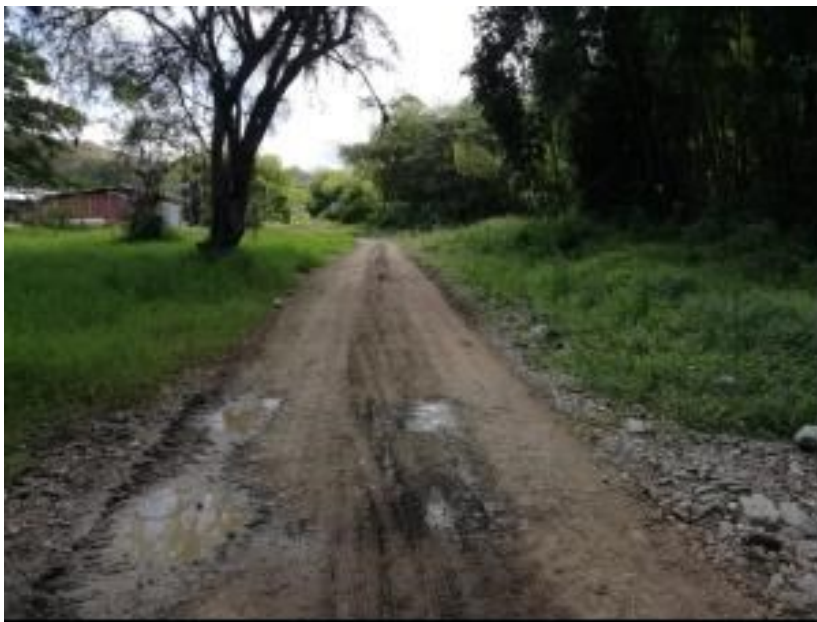
Foto 3: Detalle constructivo vía interna
