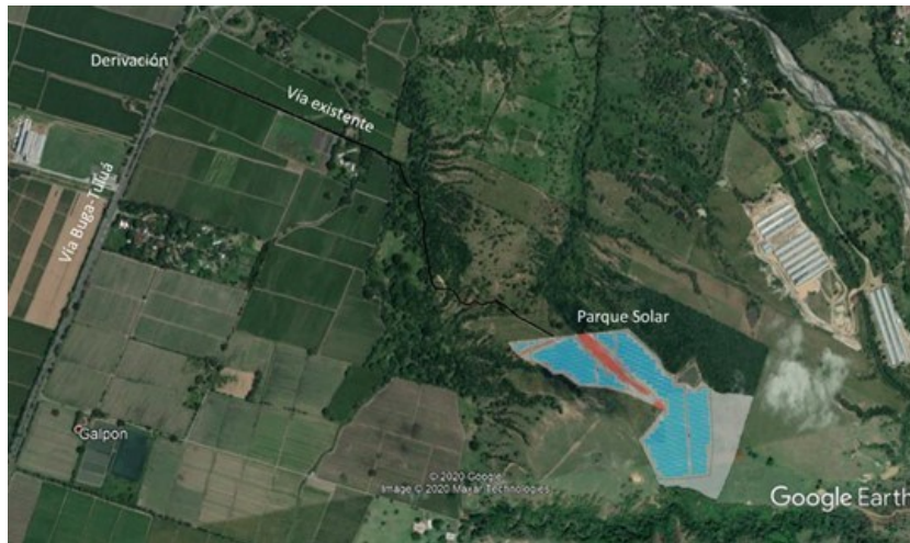
Figura 5. Vía existente para acceso al parque solar
