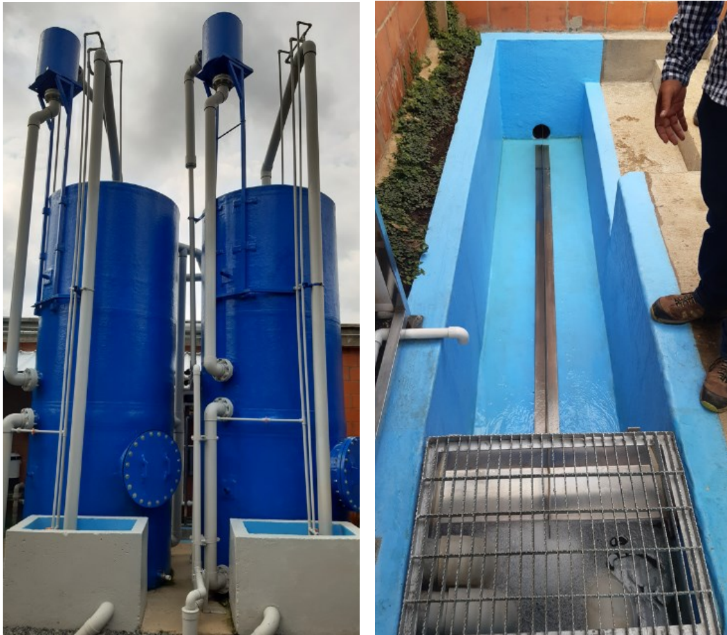
Fotografías 13 y 14. Vista de los módulos de perfeccionamiento y de la canaleta del efluente final.
