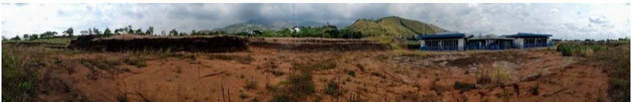
Fotografía 6: vista panorámica de área afectada por la adecuación de terreno Octubre 2020.
