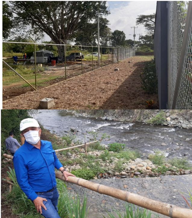
Fotografías 1 y 2. Puntos de entrada y salida de la PTAR
