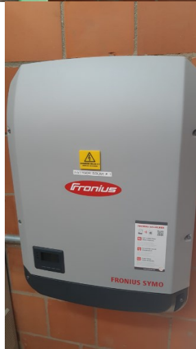
Fotografías 7 y 8. Vista de paneles solares e inversor.
