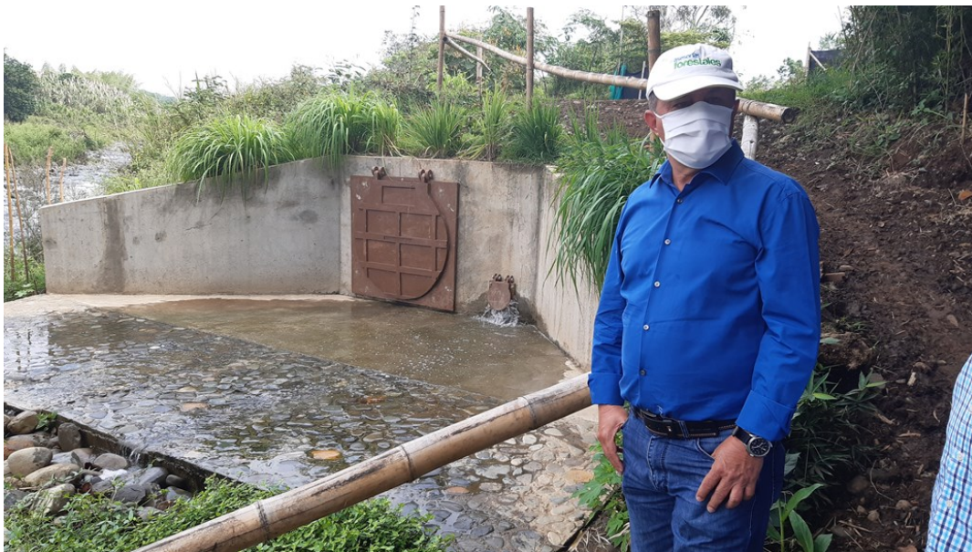
Fotografía 18. Estanque ubicado en el exterior de la PTAR, con fines de investigación de indicadores biológicos de calidad del efluente.
