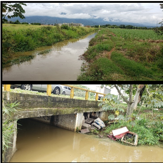
Fotos 7 y 8. Aspecto Canal del Norte alrededor del punto de vertimiento propuesto para PTAR PANGOLA.
