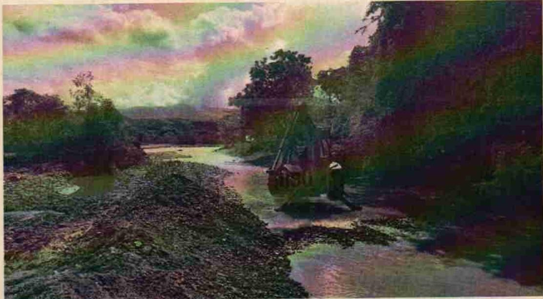
Foto No. 2. Las obras de descolmatación con maquinaria realizadas por Asoribú.
