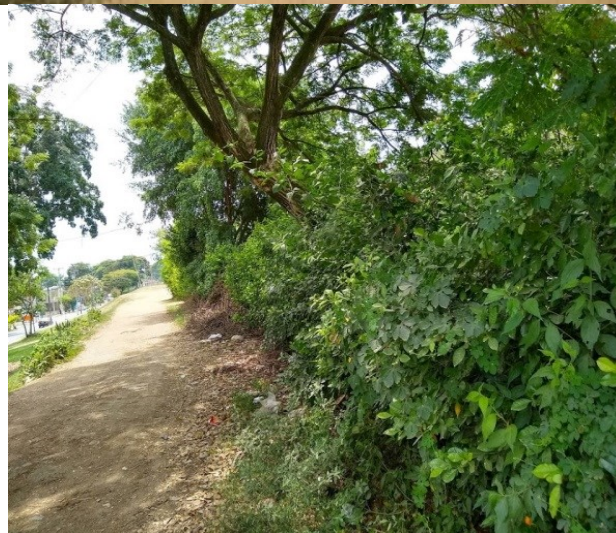
Imágenes 8 y 9. Vista general del dique (cuerpo del dique).
