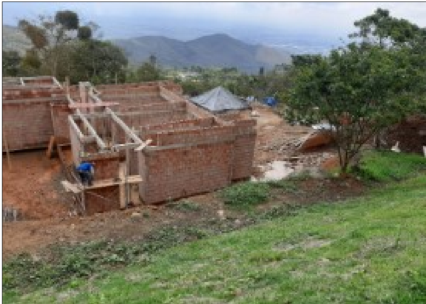
Foto No 1. La explanación para la construcción de la vivienda ya está ejecutada.
