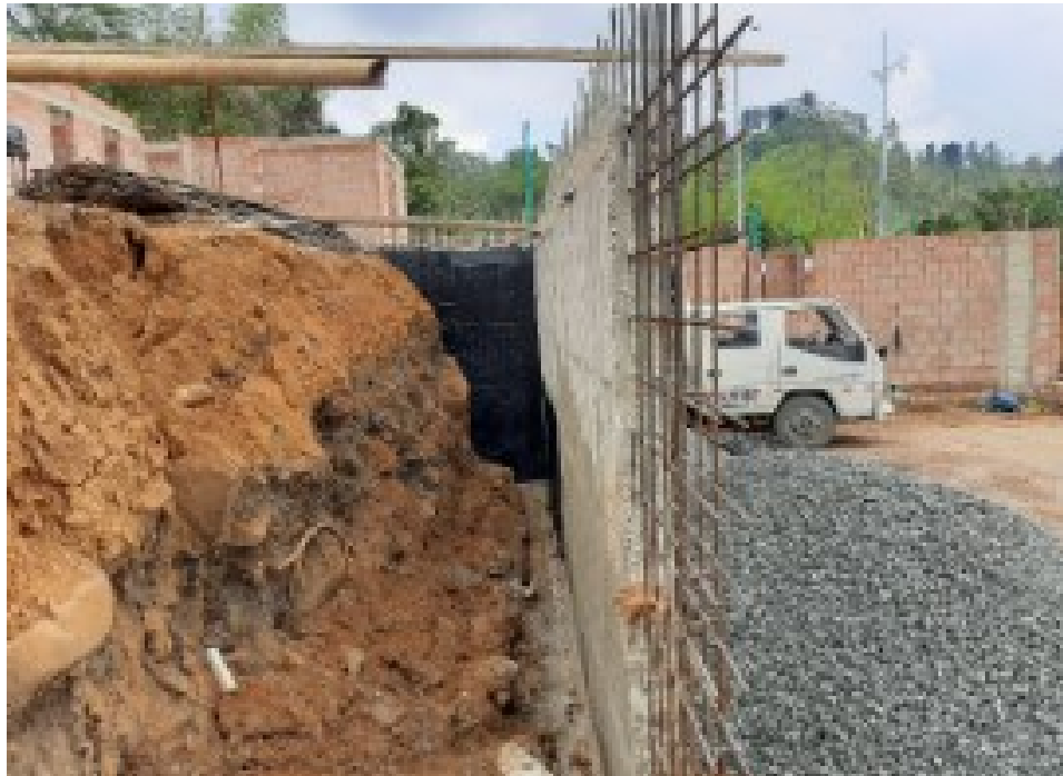
Foto No. 4. Cortes ya ejecutados.
