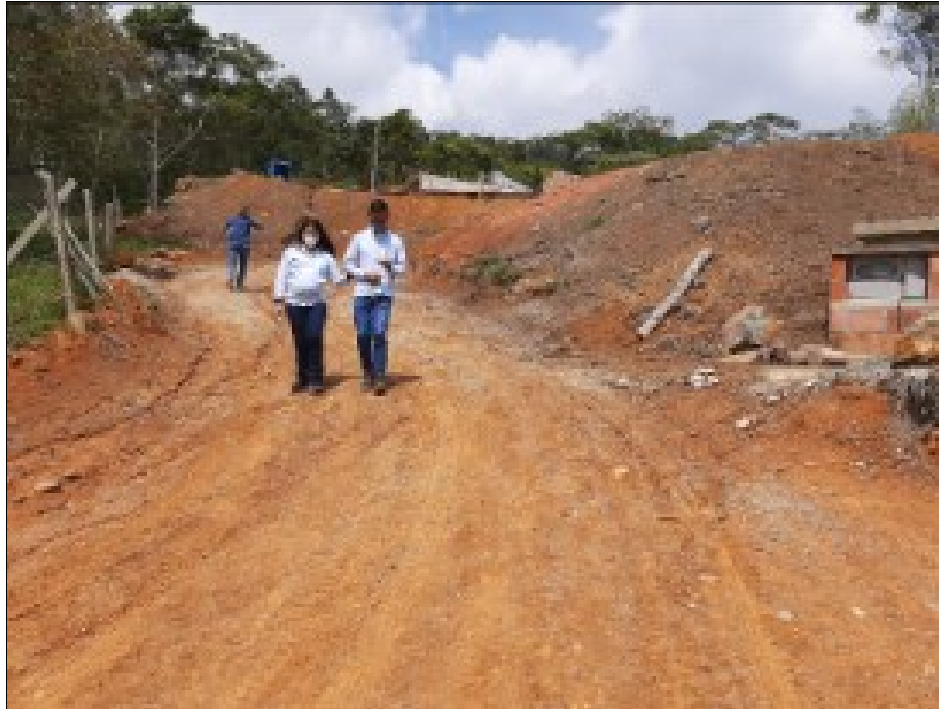
Foto No. 5. La vía de acceso al Lote2E ya está aperturada.
