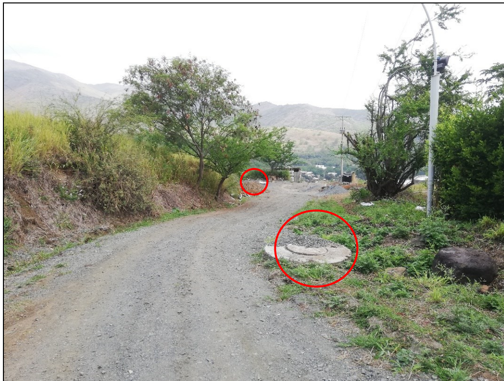
Figura 2. Vista general del acceso al Lote F11 y G18 y cajas de alcantarillado.
