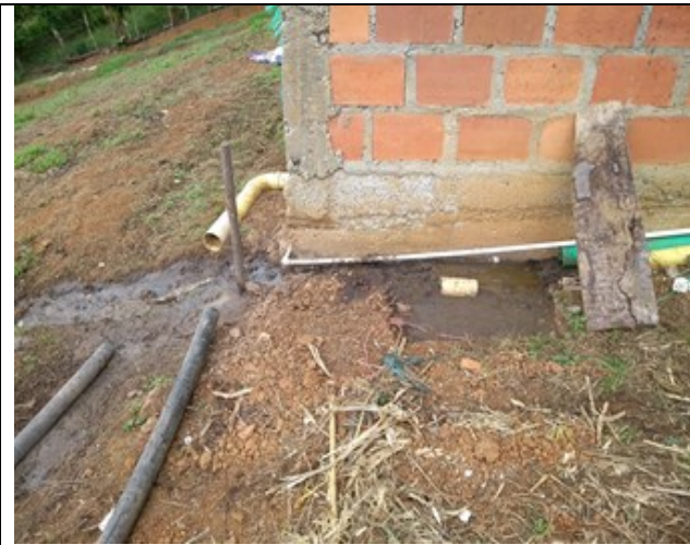
Tubería desconectada
