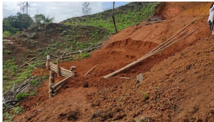
Imagen 2: Se observó escalera hecha en tierra, así mismo se observó descapote de terreno y remoción de capa de suelo en superficie de ladera.
