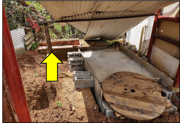
Foto No. 2. Vista en la parte posterior del taque antiguo.
