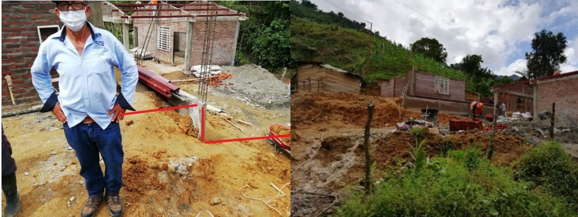
Fotos 3 y 4. Detalles y panorámica del terraceo para la construcción de las diferentes estructuras habitacionales del predio Lote 5 Rancho Alegre.
