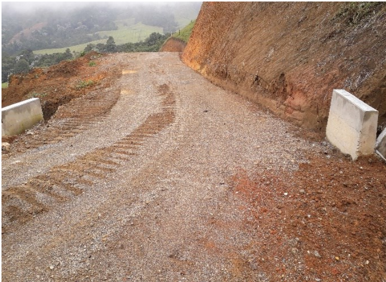
Cunetas instaladas predio El Vergel
