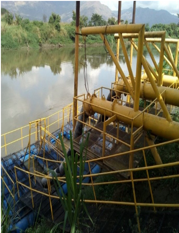
Foto 1. Captaciones margen Derecha del Río Cauca
