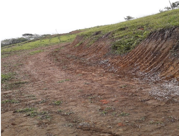
Estado de la 2da. vía sector Pueblo Nuevo
