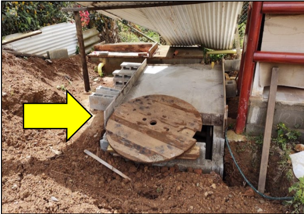
Foto No. 1. Vista frontal del tanque construido.
