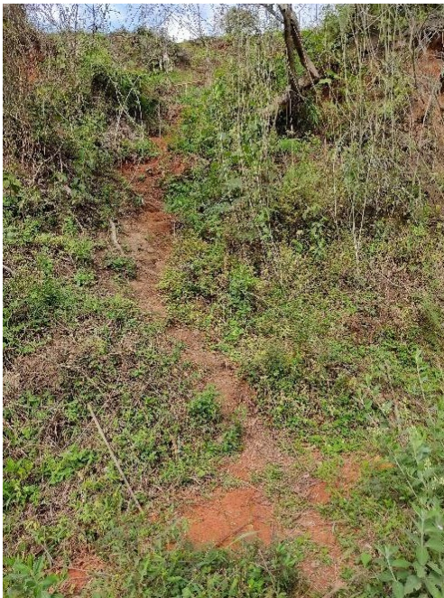
Imagen 2: Se observó escalera hecha en tierra, así mismo se observó descapote de terreno y remoción de capa de suelo en superficie de ladera.
