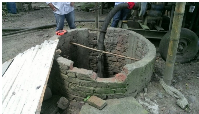
Foto No. 1 Vista General del pozo
