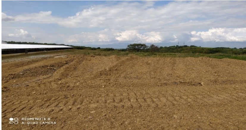
Foto 3. Obsérvese el lote en la segunda planicie que se han construido sector La Polonia N° 3- construidos tres (3) faltan por construir 7- galpones.
