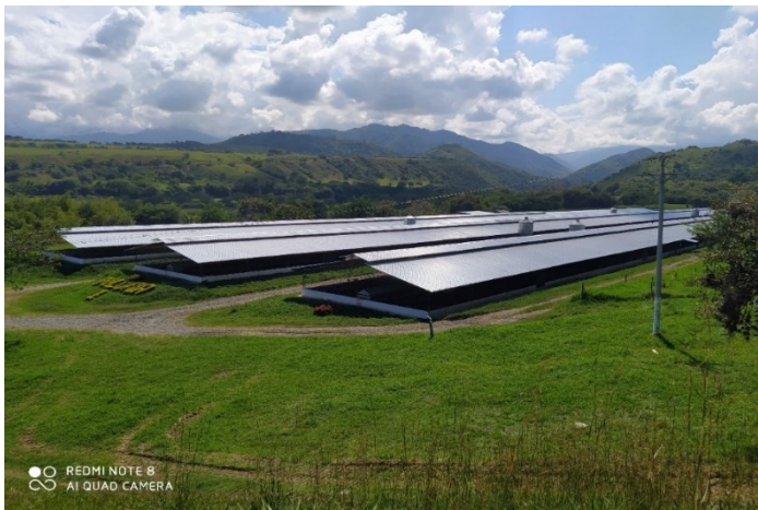
Foto 1. Obsérvese la construcción de los galpones sector La Polonia N° 1- construidos 6
