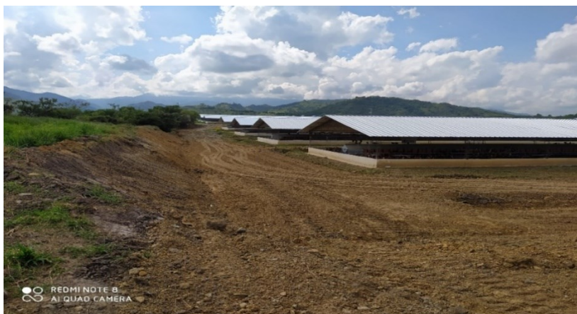
Foto 2. Obsérvese la construcción en la segunda Planicie sector La Polonia N° 2- construidos 6- faltan por construir 4, corregimiento Mateguadua, municipio de Tuluá.
