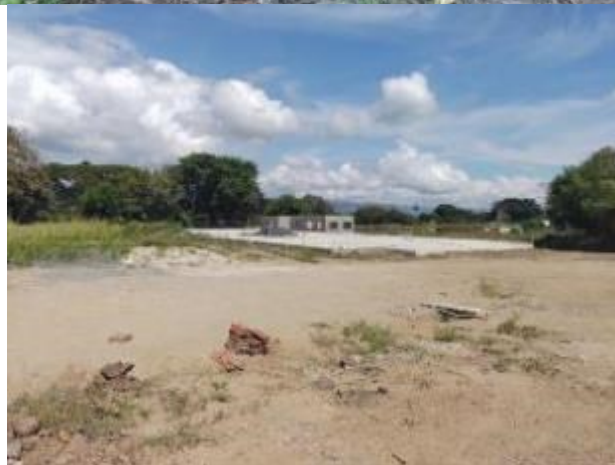
Imágenes visita técnica al predio Lote A
