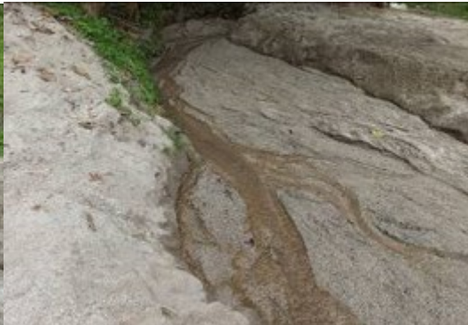
Foto No. 4. Sitio de acopio de arena y transportado por el Drenaje.
