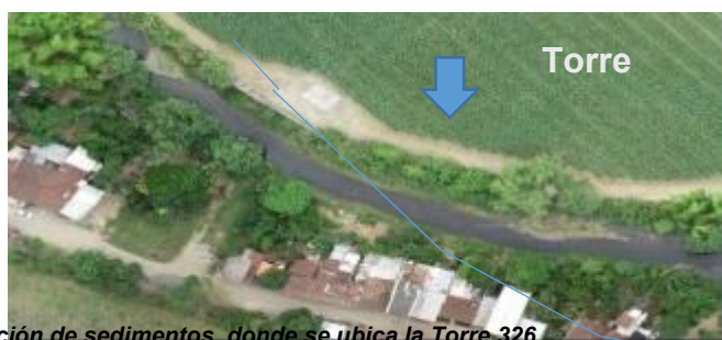
Curva convexa con acreción de sedimentos, donde se ubica la Torre 326
