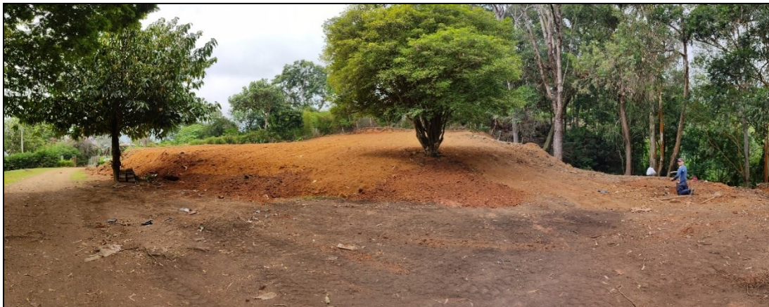
Figura 2. Vista general desde la parte inferior y de acceso a la adecuación del terreno.
