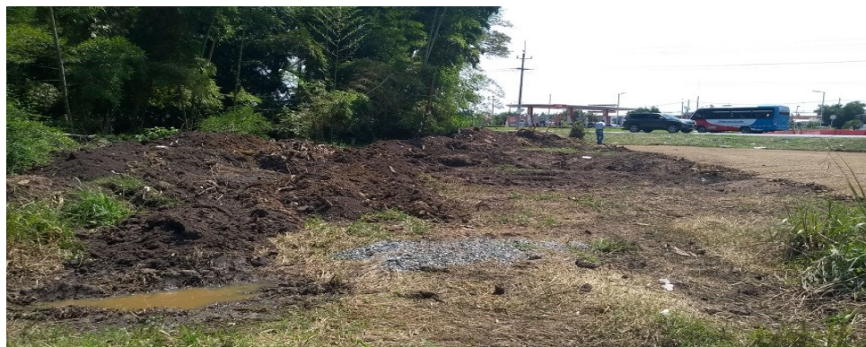
Imágenes 34, 35, 36, 37, 38, 39, 40, 41, 42, 43 y 44. Huellas de los avances de obras
