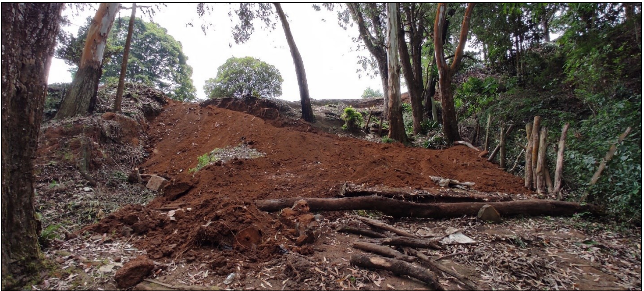
Figura 6. Vista lateral de la apertura de vía.
