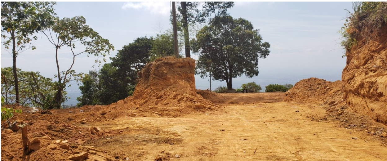
Foto 7. Entrada al predio. Explanación realizada con maquinaria pesada.
