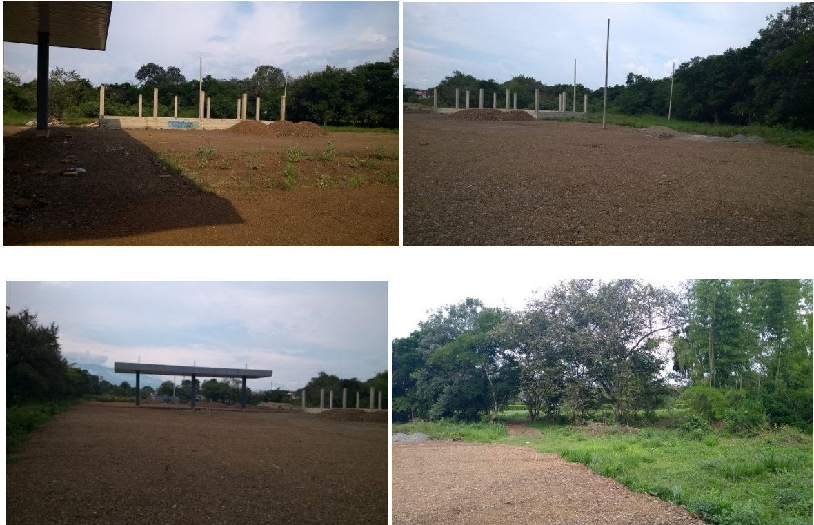
Imágenes 16,17, 18, 19, 20 y 21. Estado de las intervenciones.
