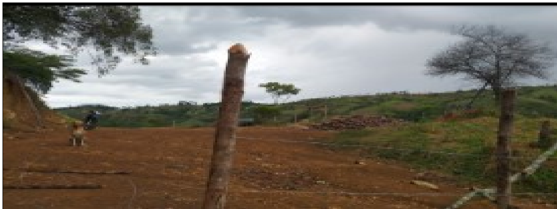
Imagen 8. Explanación – Cerco en alambre de púa
