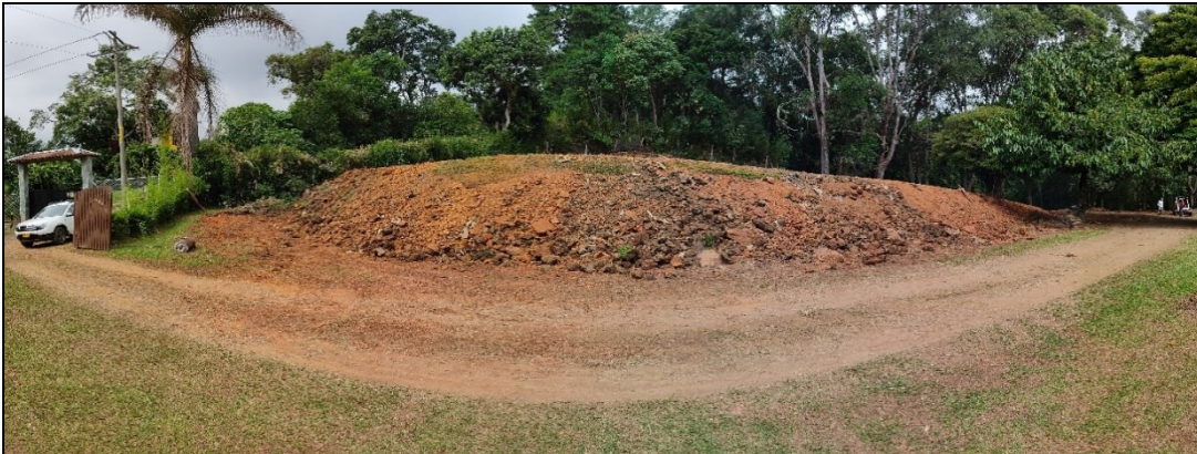
Figura 1. Vista general desde la parte: frente e inferior de la adecuación del terreno.
