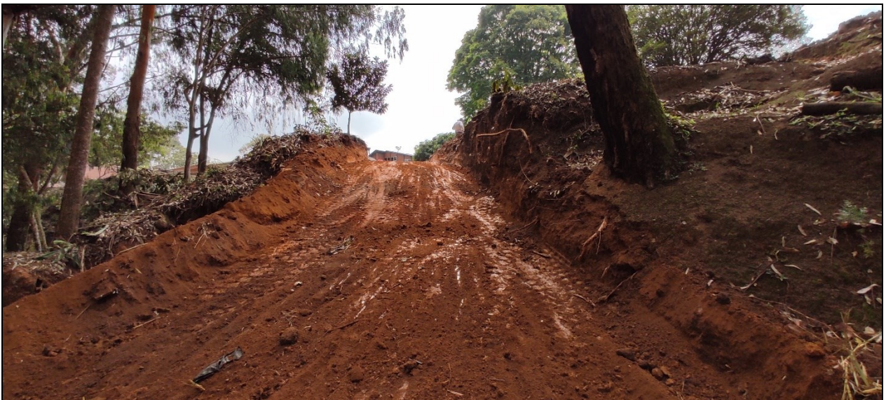
Figura 5. Vista desde la parte inferior de la apertura de vía.
