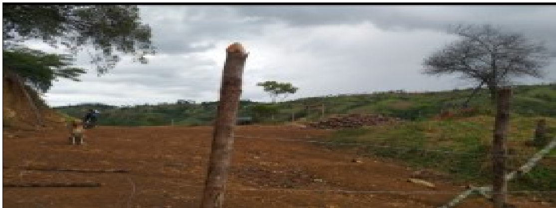
Imagen 8. Explanación – Cerco en alambre de púa
