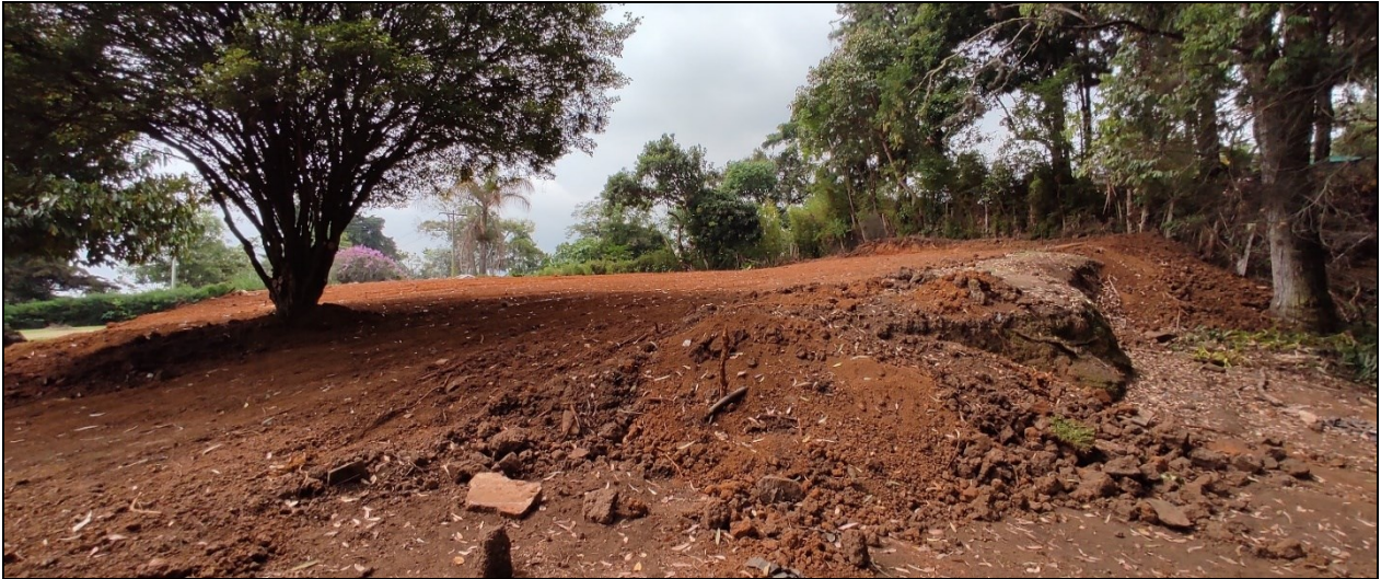
Figura 3. Vista general desde la parte lateral de la adecuación del terreno.
