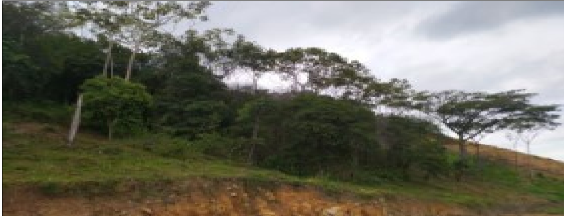
Imagen 7. Explanación - Corte y vegetación contigua.
