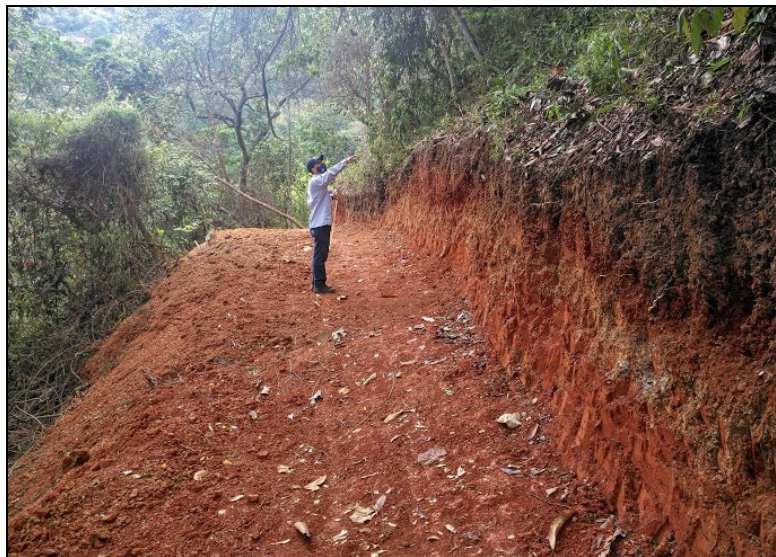
Imagen 8. Medición de los cortes de talud realizados
