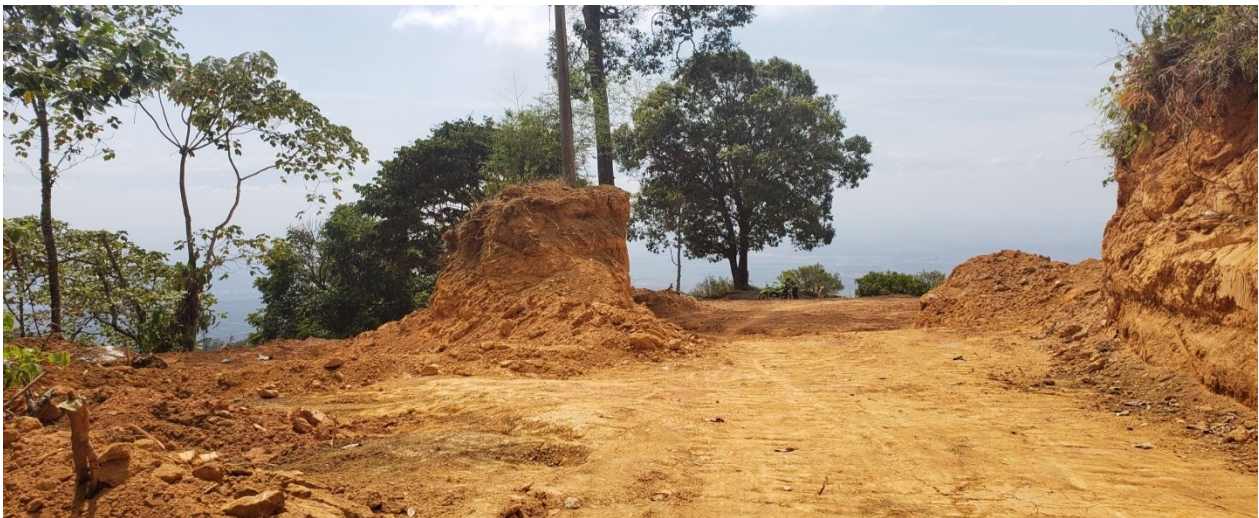
Foto 13. Entrada al predio. Explanación realizada con maquinaria pesada.
