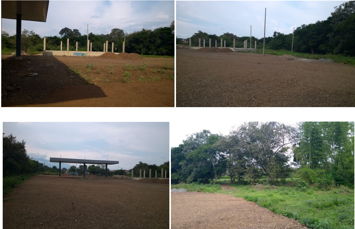
Imágenes 16,17, 18, 19, 20 y 21. Estado de las intervenciones.
