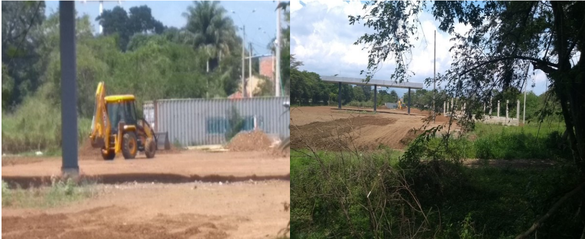
Imágenes 22 y 23. Maquinara para las explanaciones
