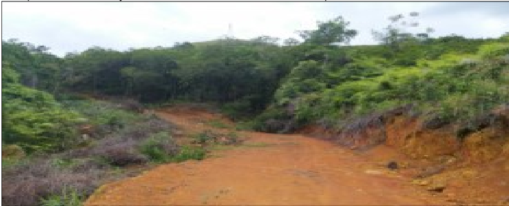
Imagen 3. Carretera que interseca la margen derecha de la carretera (Potrerito – Río Claro) hasta lugar que presenta una Explanación – Sin presencia de sistema de drenaje (cunetas, filtros, etc)
