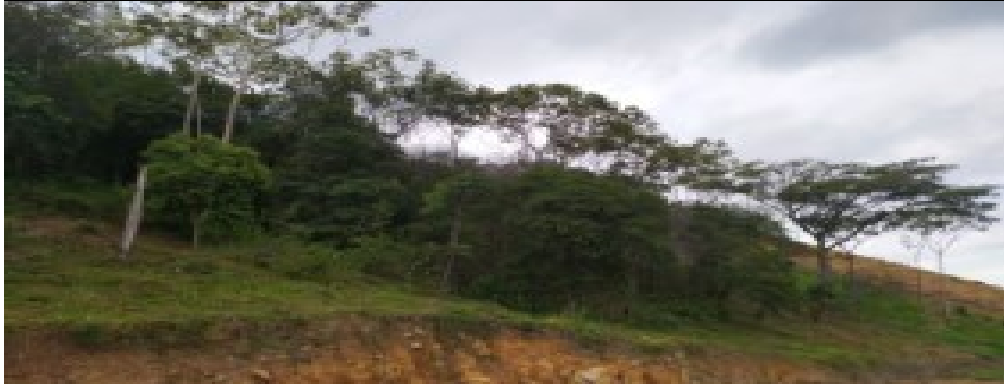
Imagen 7. Explanación - Corte y vegetación contigua.
