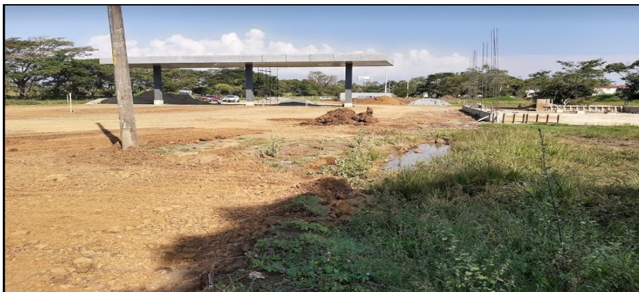
Imagen 9. Explanaciones y construcción avanzada de la EDS Porvenir Terranova
