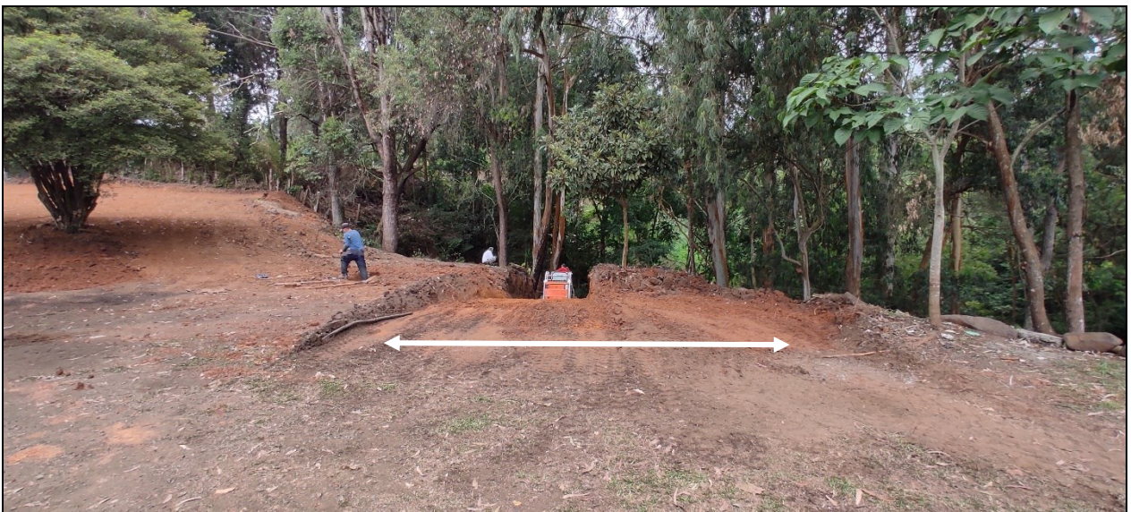
Figura 4. Vista frontal e inicio de la apertura de la vía.
