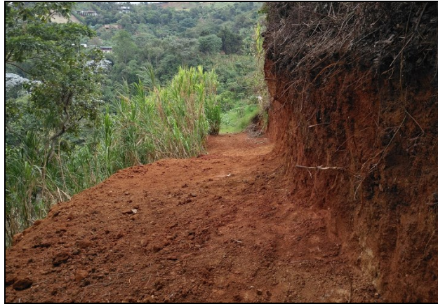
Imagen 12. Vista de la de la finalización de la vía que sale a la Parcelación Kidston, con un ancho de 3 metros.
