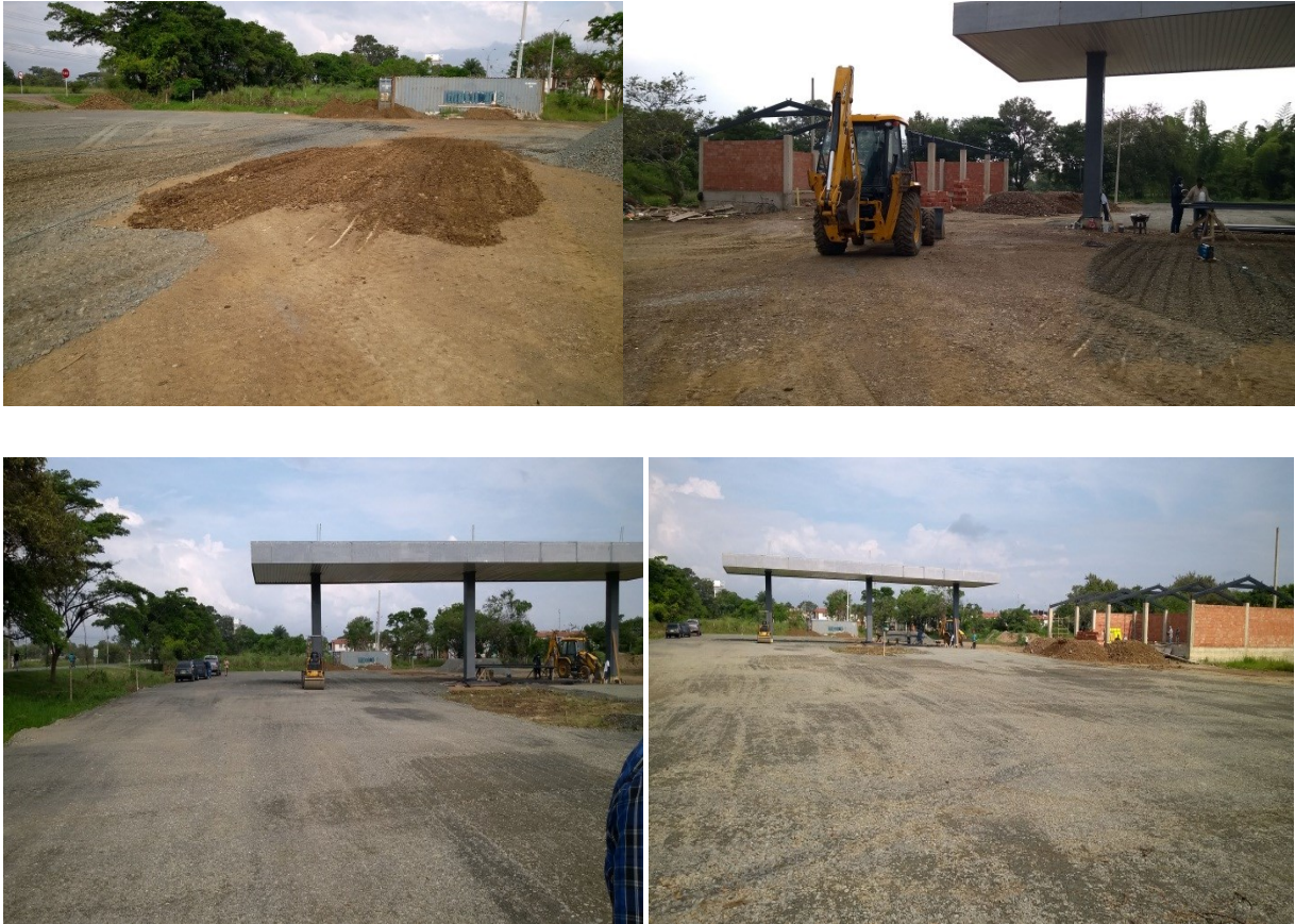
Imágenes 28, 29, 30, 31, 32 y 33. Avance de obras sin el permisos correspondiente
