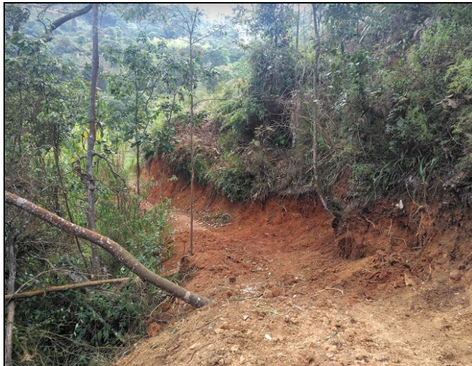
Imagen 9. Finalización de la vía con un ancho máximo de 2 metros
