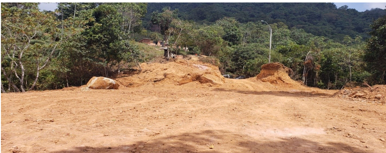
Foto 8. Dimensionamiento de la explanación realizada, foto tomada desde el interior del predio.
