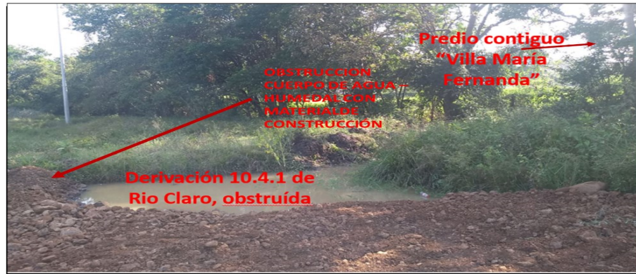
Imagen 12. Obstrucción de circulación cuerpo de agua-humedal Taponamiento con material de construcción
