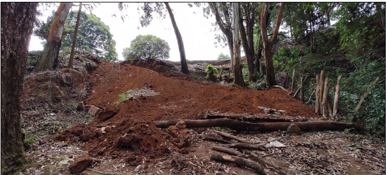
Figura 6. Vista lateral de la apertura de vía.
