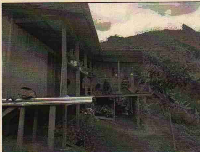
Vivienda del predio "Casa Lote La Colonia".
