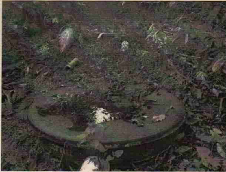
Sistema séptico en Rotoplas, para mitigar la carga por vertimientos domésticos.
