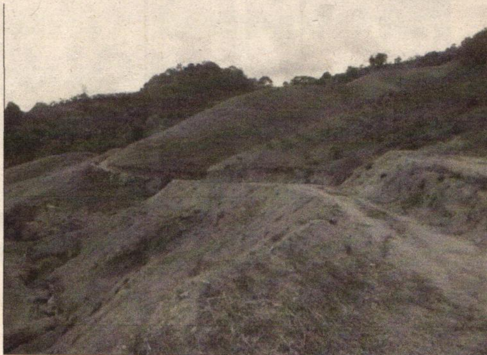
Fotografía N° 3: Apartura de vías nuevas
