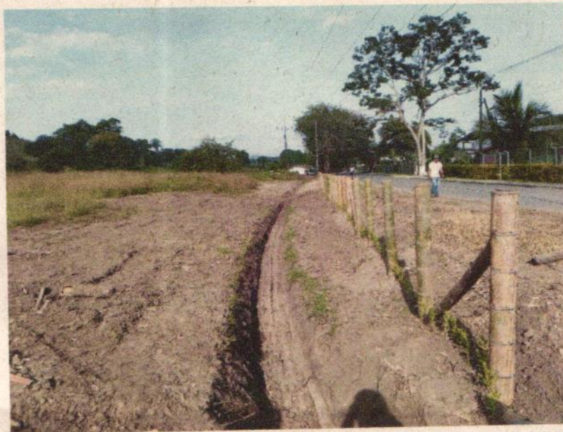
Fotografía 3: Recambio de Cerca, drenaje para conducción de aguas lluvias
