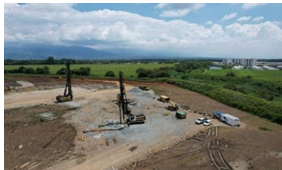
Foto 27. Construcción PTAR municipio de Jamundí Archivo CVC-2022.
