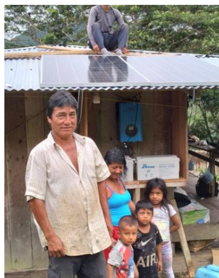
Foto 116. Instalación del sistema fotovoltaico en las comunidades beneficias del municipio de Buenaventura, Archivo CVC, 2022
