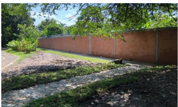
Foto 129. Instalación del Biofiltro de la Laguna de Charco Azul, Archivo CVC 2022
