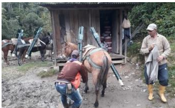
Foto 79. Instalación de aislamiento en zonas estratégicas, Archivo CVC 2022
