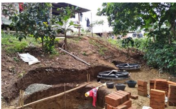
Foto 28. Etapa constructiva y de instalación de una SITAR, Archivo CVC-2022.
