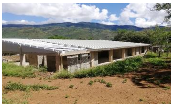
Foto 130. Obra construcción de la sede administrativa de la DAR Pacífico en Dagua, Archivo CVC, 2022,
