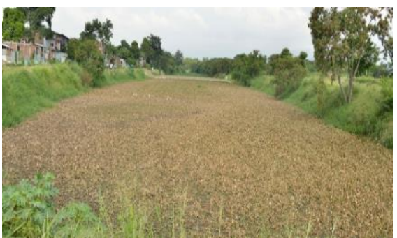
Foto 128. Instalación del Biofiltro de la Laguna de Charco Azul, Archivo CVC 2022
