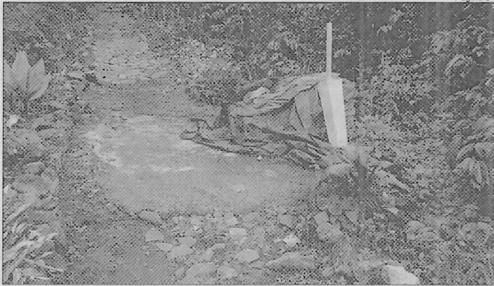
Tanque séptico para el manejo de vertimientos domésticos
