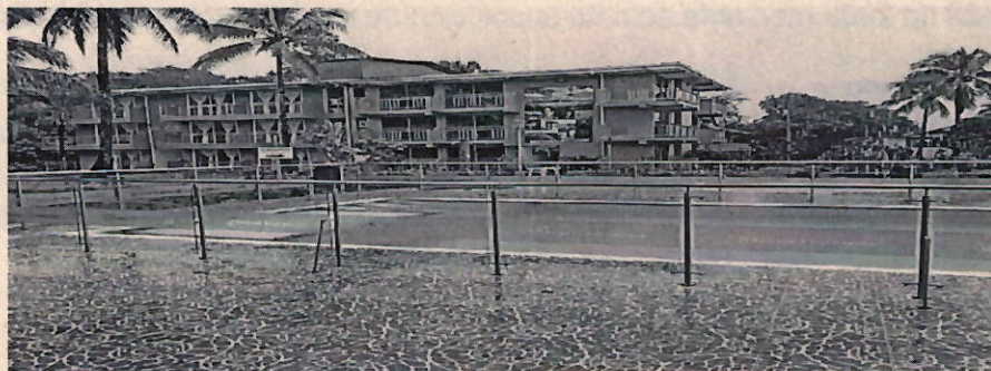
Foto 1. Vista frontal del Hotel Reserva Aguamarina, Ladrilleros.
