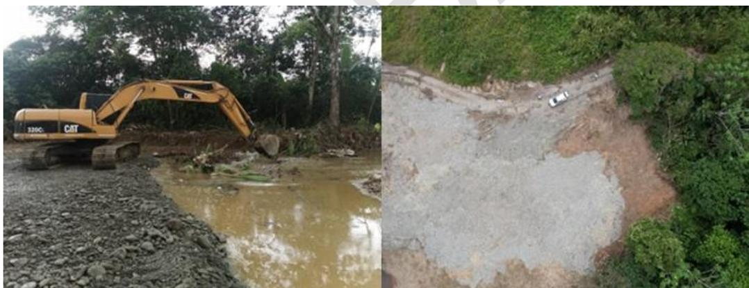
Foto 17. Relleno de fosas mediante la disposición de conglomerado de río en el municipio de Buenaventura, Archivo CVC-2022.
