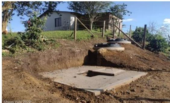
Foto 50. Fundación de tanque séptico para Sistema de Tratamiento en Ulloa, Archivo CVC-2022.
