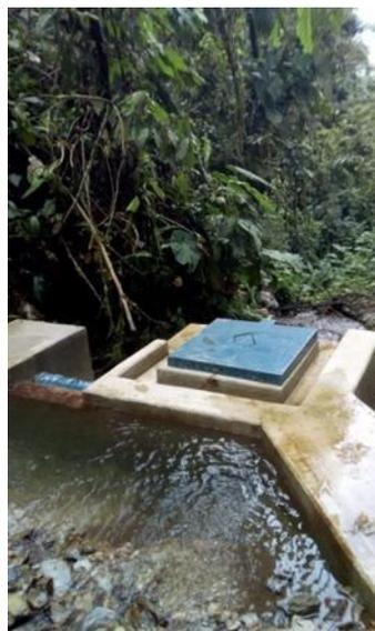
Foto 60. Estructura de captación para el sistema de abastecimiento implementado en el municipio de Jamundí, Archivo CVC-2022.
