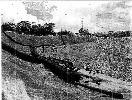
Fotografía 3: área ampliada vaso optimizado 1, costado izquierdo (lado B) visto desde enfrente. Capacidad de la ampliación del vaso 1 optimizado : 117.300 m 3 , con una tasa de disposición de 185 Ton/diarias y una vida útil de 22 a 23 meses.
