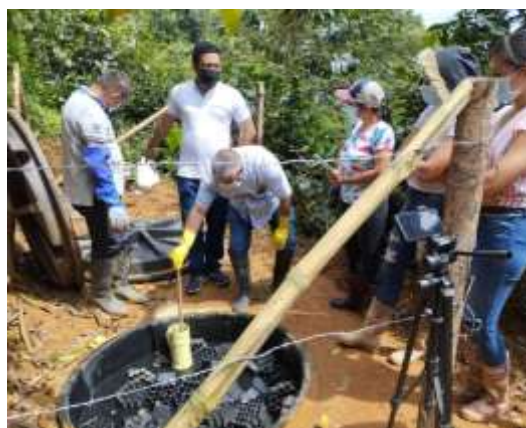
Foto 38. Sistema individual de tratamiento de agua residual doméstica – Mantenimiento, Archivo CVC.
