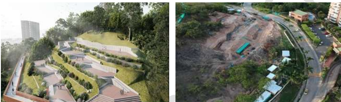
Foto 140. Corredor Ambiental Cristo Rey Tramo III, en la ciudad de Cali. Fuente: Archivo CVC, 2023.
