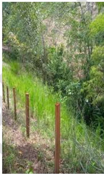
Foto 6. Implementación de HMP de Aislamiento de Protección y Cerca Viva-Predio El Porvenir-Vereda Coloradas-Mpio. de Cartago
