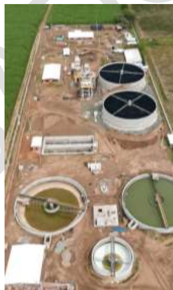
Foto 34. Avance en la construcción de la PTAR de la cabecera municipal de Buga. Archivo CVC.
