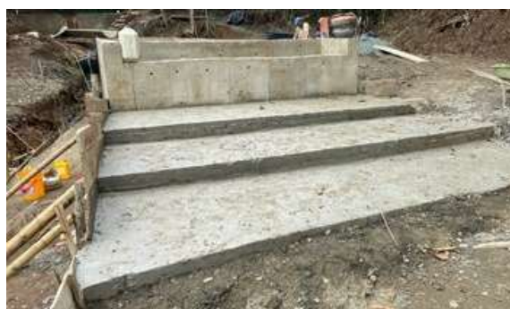
Foto 139. Construcción de desarenador en el Lago del Ecoparque de la Bandera. Fuente: Archivo CVC, 2023.
