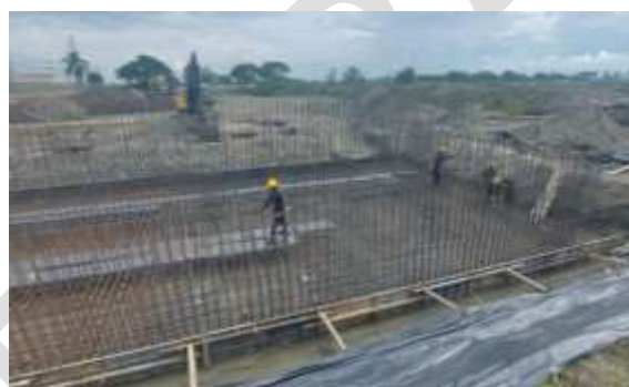
Foto 32. Avance en la construcción de la PTAR para los corregimientos El Carmelo, San Joaquín, Villagorgona y Buchitolo en el municipio de Candelaria. Archivo CVC.
