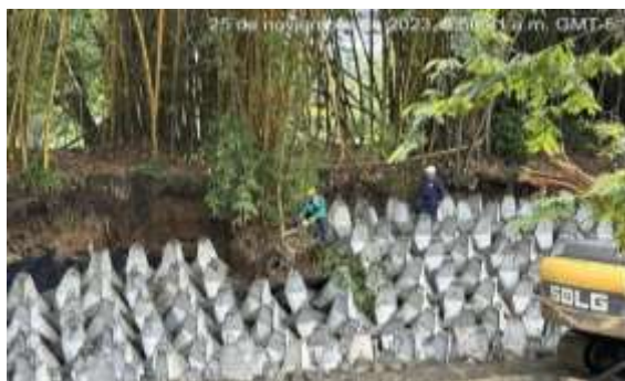
Foto 156. Avance de obras de gestión del riesgo, río Meléndez. Fuente: CVC 2023
