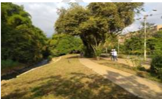
Foto 155. Avance de obras de gestión del riesgo, río Cañaveralejo Fuente CVC, 2023
