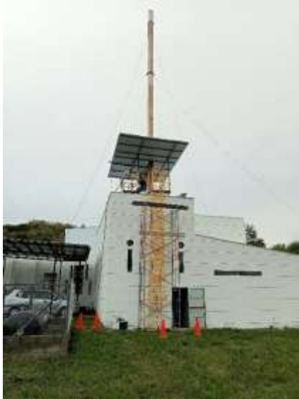
Foto 109. Monitoreo de fuentes fijas, plataforma de incineradora (Vista 1). Archivo CVC, 2023
