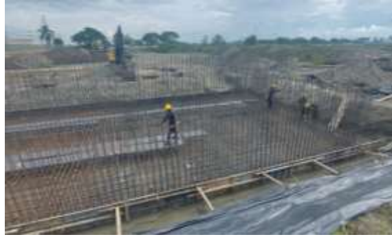
Foto 33. Avance en la construcción de la PTAR para los corregimientos El Carmelo, San Joaquín, Villagorgona y Buchitolo en el municipio de Candelaria. Archivo CVC, 2023.
