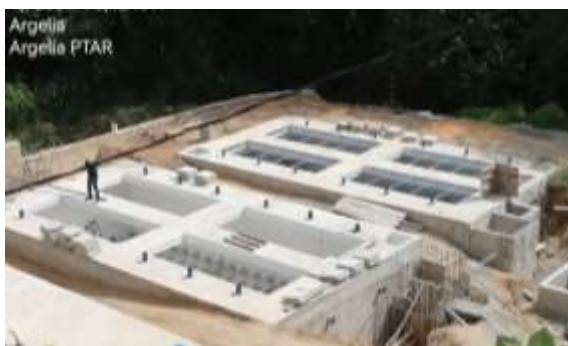
Foto 36. Avance en la construcción de la PTAR de la cabecera municipal de Argelia. Archivo CVC. 2023
