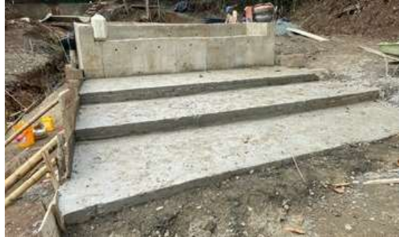
Foto 158. Construcción de desarenador en el Lago del Ecoparque de la Bandera. Fuente: Archivo CVC, 2023.
