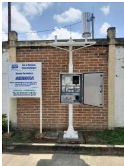
Foto 129. Estación pluviométrica - municipio de Ansermanuevo. Archivo CVC.
