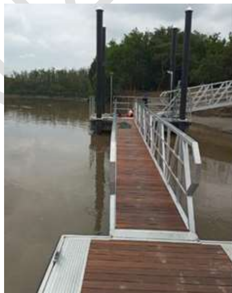
Foto 83. Etapa Constructiva Embarque Videles (detalle 2). Fuente: Archivo CVC, 2023
