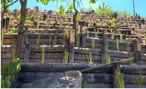
Foto 157. Obras de bioingeniería en el Ecoparque de la Bandera. Fuente: Archivo CVC, 2023.
