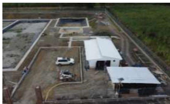
Foto 37. Avance en la construcción de la PTAR del corregimiento Zanjón Hondo. Archivo CVC. 2023
