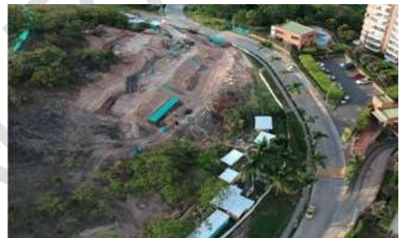
Foto 160. Corredor Ambiental Cristo Rey Tramo III, en la ciudad de Cali (Vista 2). Fuente: Archivo CVC, 2023
