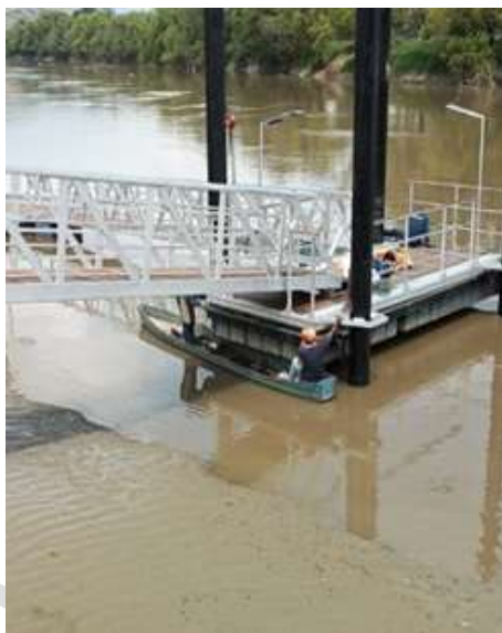
Foto 82. Etapa Constructiva Embarque Videles (detalle 1). Fuente: Archivo CVC, 2023
