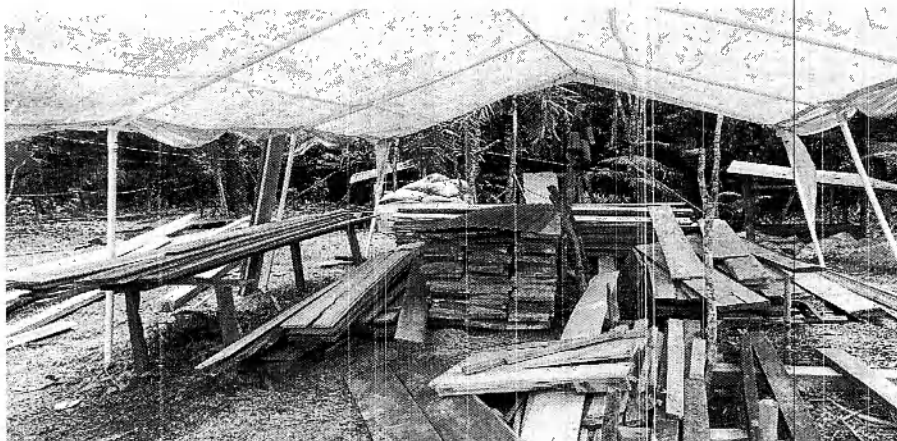
Foto 1. Piezas de madera de diferentes especies almacenadas para su uso en el proceso constructivo y de adecuación de las instalaciones del Hotel Melo - Corregimiento de Ladrilleros - Bahía Málaga.
