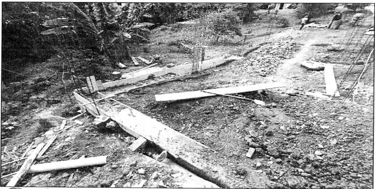
Foto 3. Vista de la viga de amarre fundida en concreto en el perímetro de la obra
