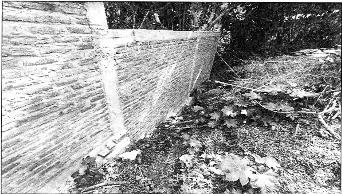
Foto 4. Vista de la pared de cerramiento construida en el lindero oriente del predio.
