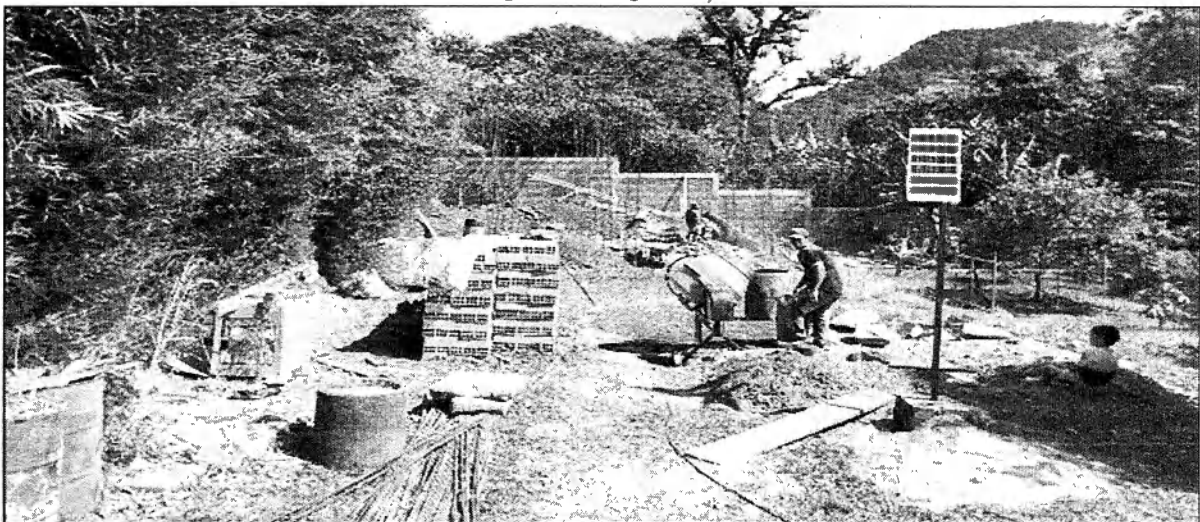
Foto 1. Vista general de la intervención encontrada
