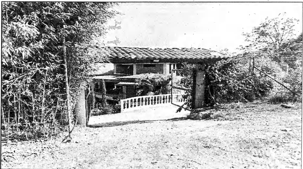
Foto 7. Vista de la portada del predio.
