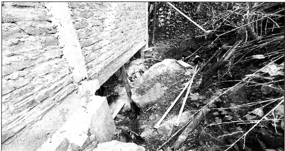
Foto 5. Vista de la apertura de la pared sobre el cauce de la quebrada Las Brisas
