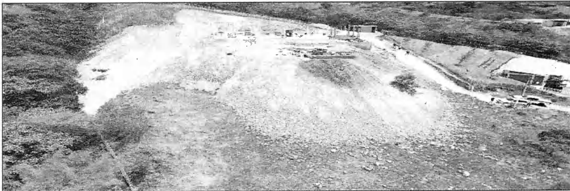
Foto 1. Vista general de los movimientos de tierra realizados.
