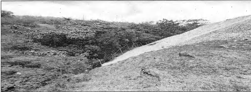
Foto 3. Vista lateral del material producto de excavación hacia área forestal protectora de corrientes intermitentes (lindero sur)
