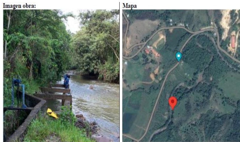
Figura 2-13. Descripción de obra hidráulica 1
