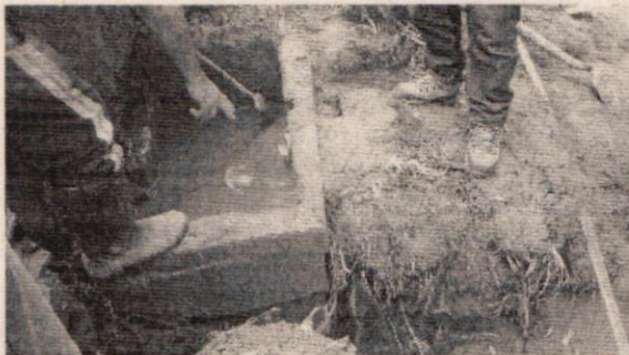
Fotografías 1 y 2. Caja de registro y pozo de absorción con paredes fracturadas.
