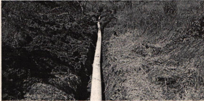
Zanja sobre el drenaje natural con tubería.
