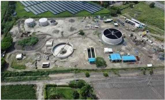
Foto 74. Construcción de la PTAR corregimientos El Carmelo, San Joaquín, Villagorgona y Buchitolo en el municipio de Candelaria. Archivo CVC, 2025.
