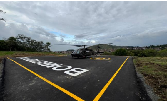
Foto 113. Adecuación de Helipunto para la ejecución de Operaciones con Apoyo aéreo en Incendios Forestales en Santiago de Cali. Archivo CVC, 2025
