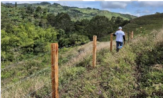
Foto 82. Implementación Aislamiento de Protección - Predio El Porvenir. Cuenca Pescador. Archivo CVC, 2025.
