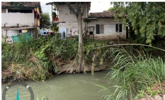
Foto 101. Registro fotográfico de la visita de reconocimiento al municipio de Guacarí. Archivo CVC, 2025.
