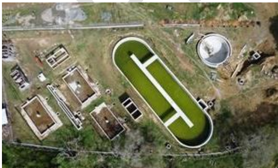
Foto 75. Construcción de la PTAR de la cabecera municipal de El Dovio. Archivo CVC, 2025.
