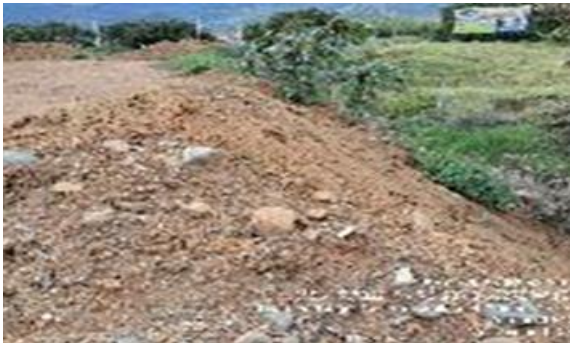
Foto 108. Recorrido Proyecto de Urbanismo “Portal de San Isidro” Calima El Darién. Archivo CVC, 2025.
