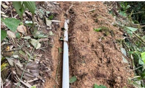
Foto 86. Excavación de zanjas e instalación de tuberías en el proceso de optimización del sistema de abastecimiento de agua para la Comunidad Indígena Join Jeb en el municipio de Buenaventura. Archivo CVC, 2025.
