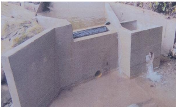
Foto 85. Optimización de la estructura de captación en el sector El Cajón. Archivo CVC, 2025.
