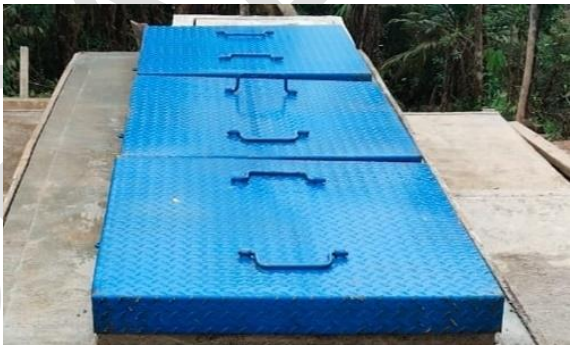
Foto 88. Tanque desarenador construido para el sistema de abastecimiento de agua para la comunidad indígena Yu Yik Kwe en el Municipio de Dagua. Archivo CVC, 2025.
