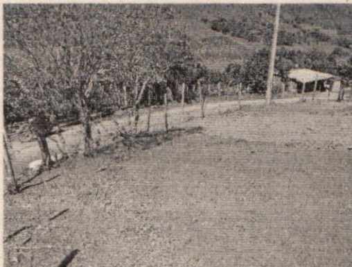
Fotografías. Descapote de un acceso cuyo ancho de vía es de 2,5 metros
