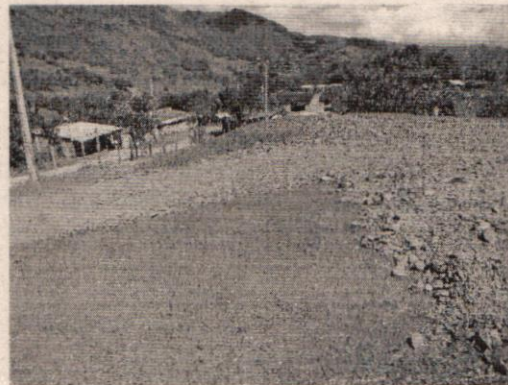
Fotografías. Descapote de un acceso cuyo ancho de vía es de 2,5 metros
