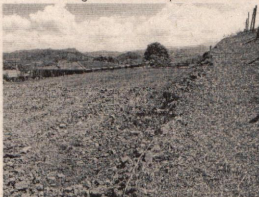
Fotografías. Descapote de un acceso cuyo ancho de vía es de 2,5 metros
