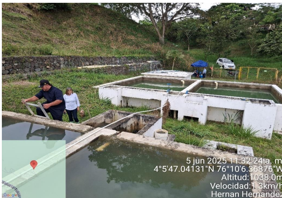
Imagen 3. Detalle donde se realiza la purga para mejorar la remoción de lodos depositado dentro del cumplir lecho, DAR Centro Norte de la CVC.
